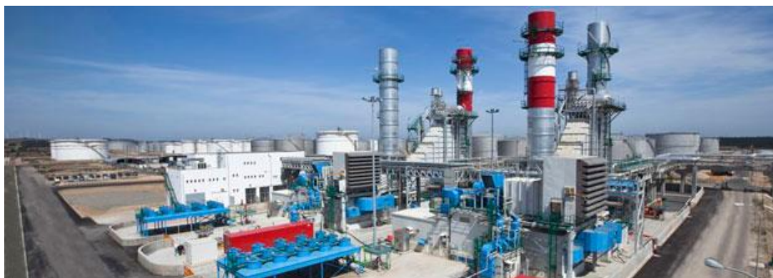
Figura 9 - Central de Cogeração do Carriço Fonte: http://intranet.edp.pt
