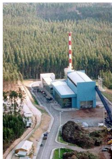
Figura 10 - Central de Mortágua Fonte: http://intranet.edp.pt
