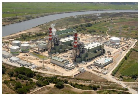
Figura 11 - Central de Ciclo Combinado de Lares Fonte: http://intranet.edp.pt
