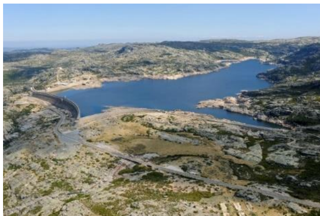
Figura 16 - Vista aérea da barragem da Lagoa Comprida Fonte: http://intranet.edp.pt
