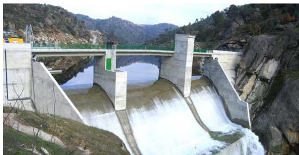
Figura 13 - Barragem de Bouçoais Fonte: http://intranet.pt
