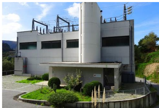
Figura 19 - Central de Vila Cova Fonte: http://intranet.edp.pt
