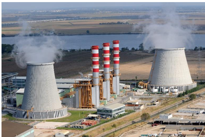
Figura 12 - Central de Ciclo Combinado do Ribatejo Fonte: http://intranet.edp.pt
