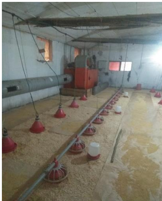
Figura 37: Sistema de aquecimento e equipamentos de alimentação
