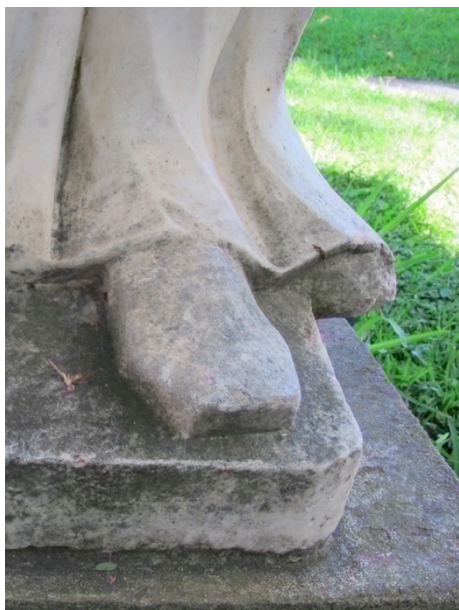
Figura 10- Fotografia referente à qualidade de execução da base da escultura nº 773 Esc.
