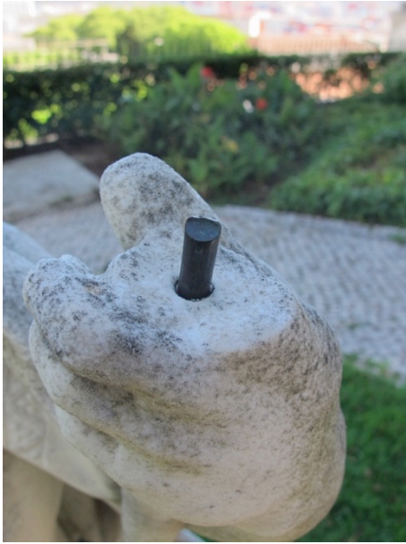
Figura 38- Pormenor de uma mão da escultura nº 2480 Esc. Fotografia, de carácter exemplificativo da patologia designada por elemento metálico oxidado.
