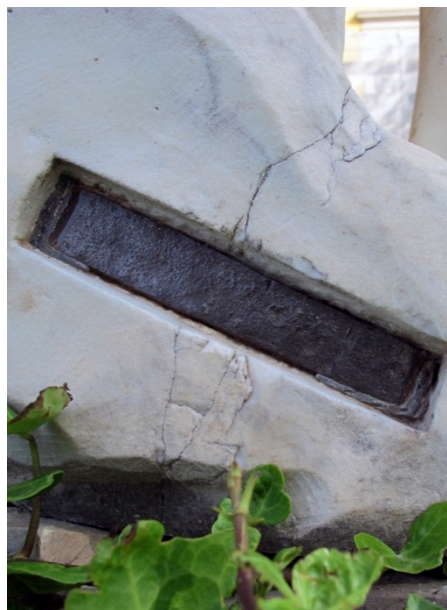
Figura 110- Fotografia obtida após a finalização da intervenção do “gato metálico”.
