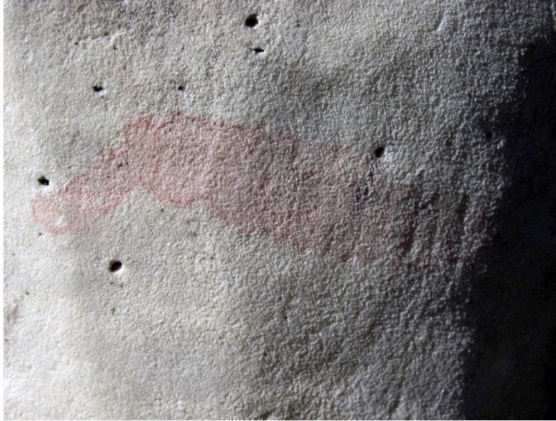
Figura 33- Fotografia, segundo vista posterior, da escultura nº 772 Esc. Identificação da patologia designada por mancha cromática.
