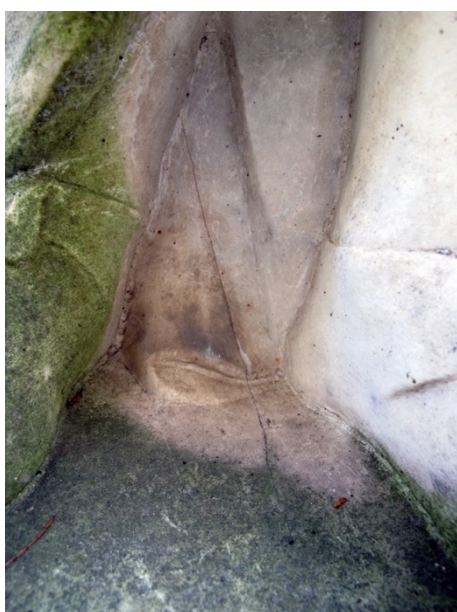
Figura 19- Fotografia de uma fissura existente na escultura com número de inventário 772 Esc.
