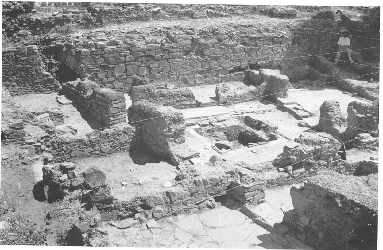
Fig. 10. Paredes em taipa e alvenaria.
