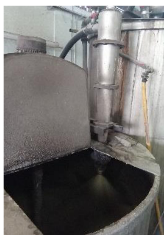
E: Concentrador de precipitado munido de hidrociclone
