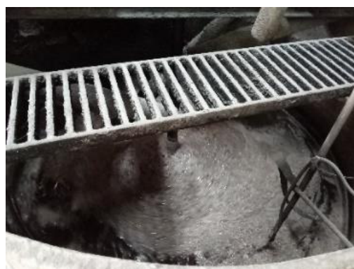
D: Tanque de homogeneização
