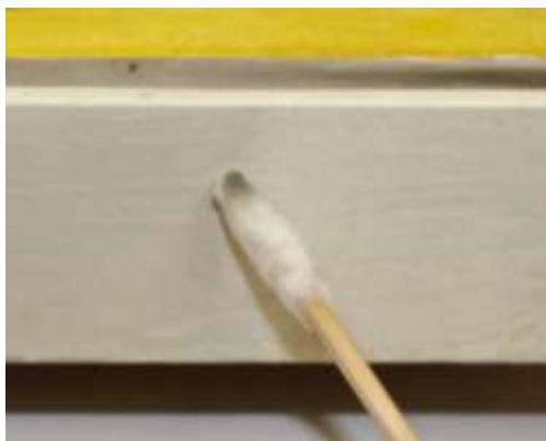
Figura 71 - Limpeza da moldura com white spirit .
