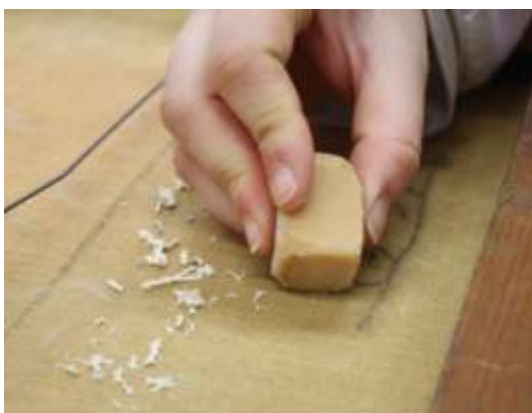
Figura 72 - Limpeza do verso com auxílio de uma borracha.
