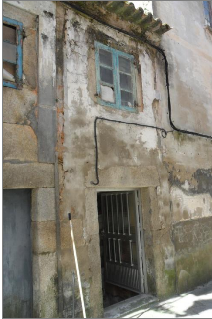
Fig. 92. Fachada Norte. Caso 1.
