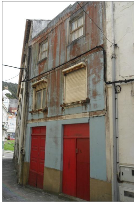
Fig. 1. Fachada Norte. Caso 2.
