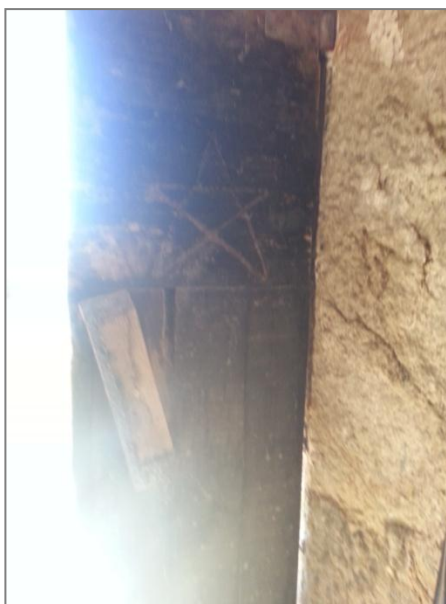
Fig. 135. Detalle puerta. Caso 2.
