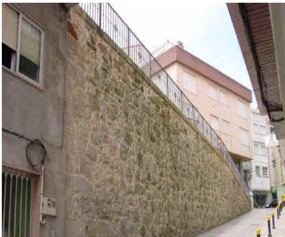
Fig. 31. Muralla existente en la Rúa Ireira.
