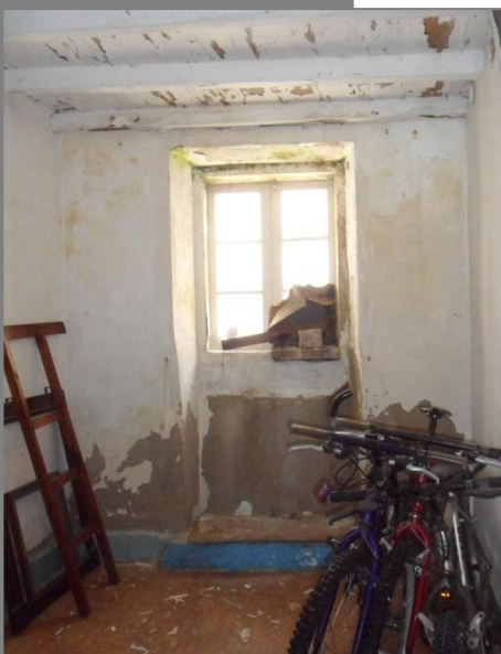
Fig. 76. Interior vivienda. Estar planta 1.
