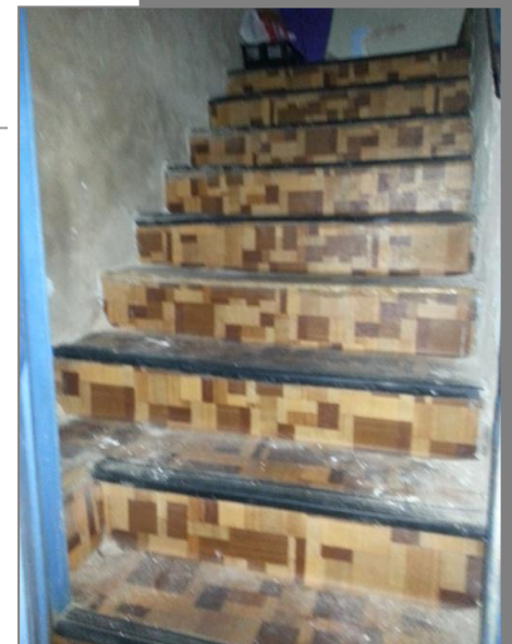
Fig. 111. Escaleras Planta Baja.
