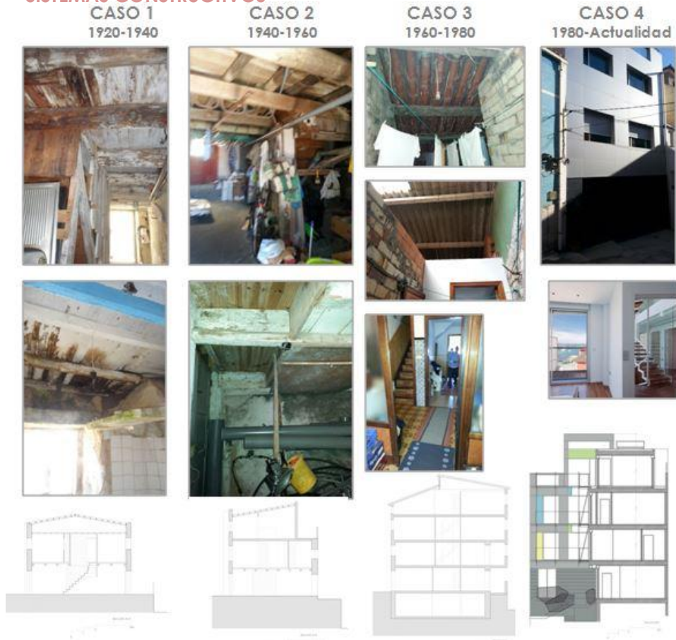
Fig. 206. Imagen comparativa de los Sistemas Constructivos de los estudio de caso del Barrio de A Marina
