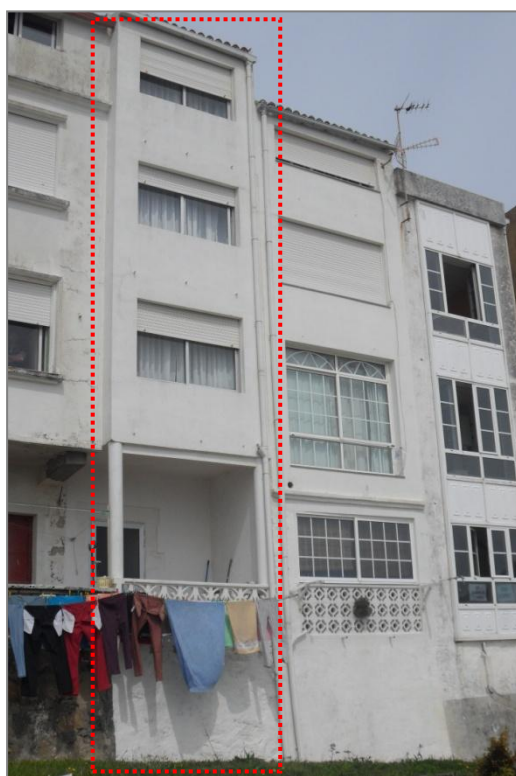
Fig. 163. Fachada Sur. Actualidad.
