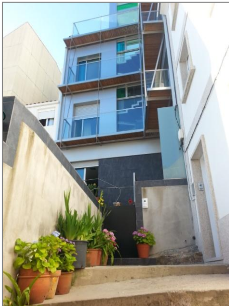
Fig. 199. Fachada Sur. Caso 4.
