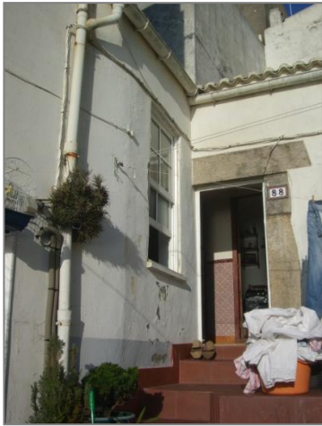
Fig. 189. Vivienda antes de la construcción.
