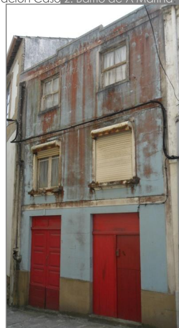
Fig. 103. Fachada Norte Caso 2.
