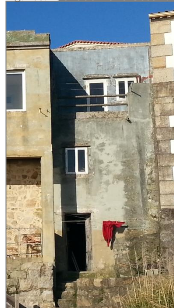
Fig. 104. Fachada Sur Caso 2.
