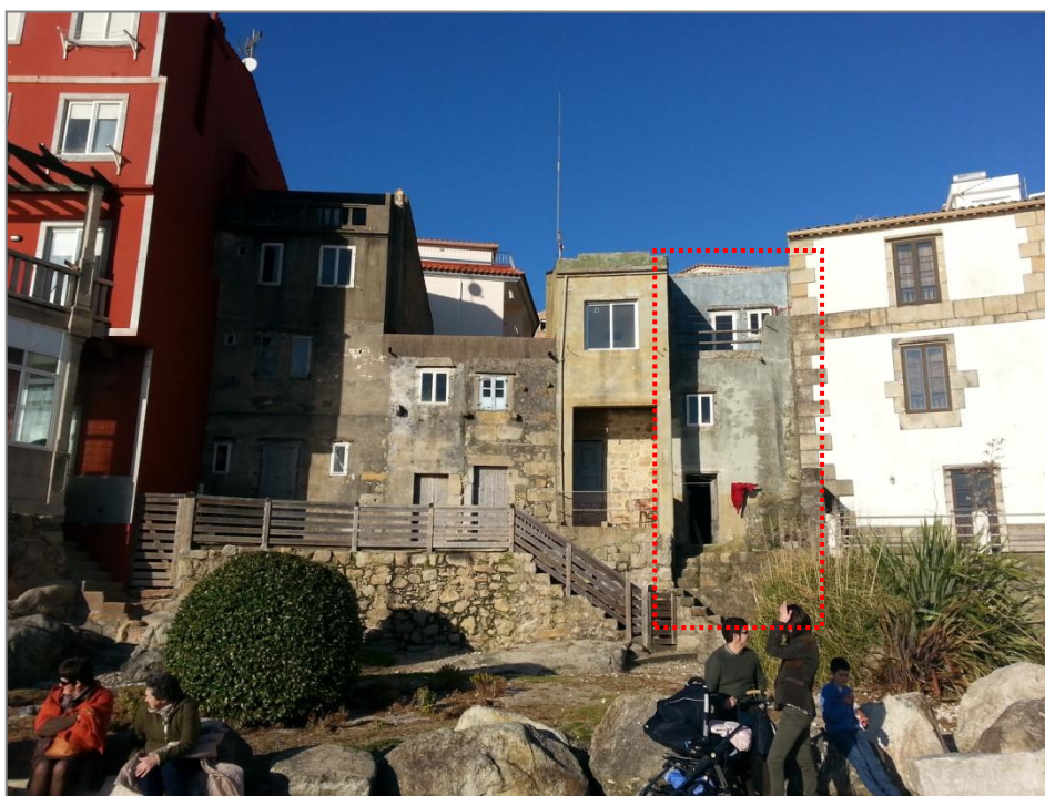
Fig. 123. Fachada Sur actual.
