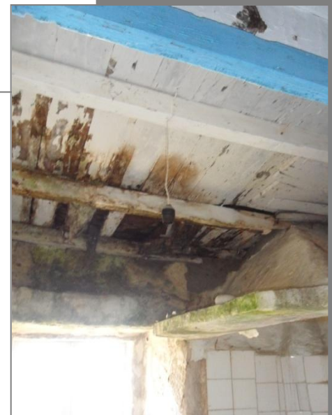
Fig. 1 Interior vivienda. Forjado Cubierta
