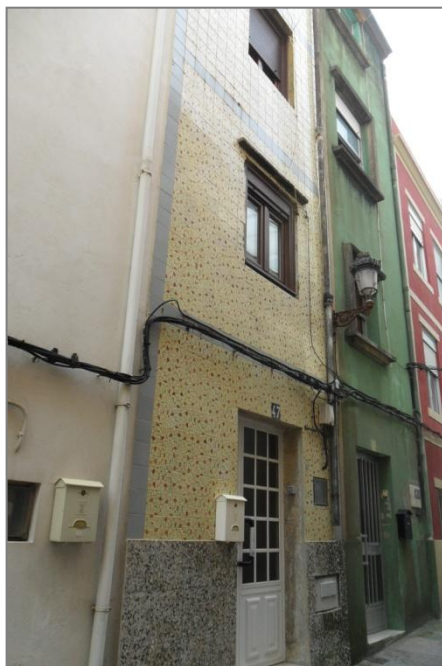
Fig. 164. Fachada Norte. Caso 3.
