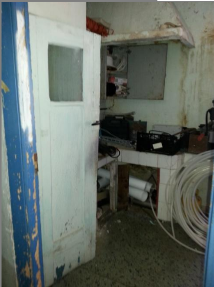
Fig. 106. Interior vivienda. Cocina.
