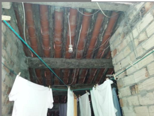
Fig. 147. Interior vivienda. Cubierta.
