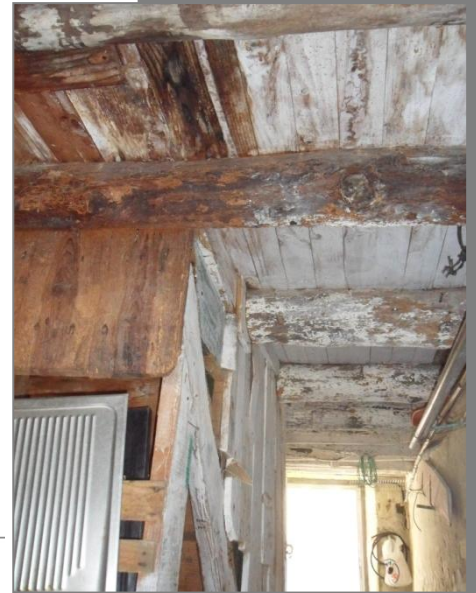
Fig.77. Interior vivienda. Forjado
