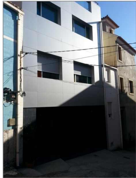
Fig. 200. Fachada Norte. Caso 4.
