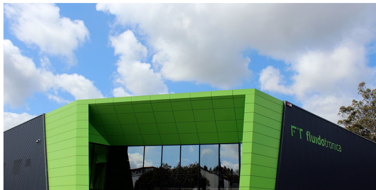
Figura 1.1: Instalações da empresa Fluidotronica
