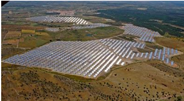
Figura 19 – Central Fotovoltaica da Amareleja [32]
