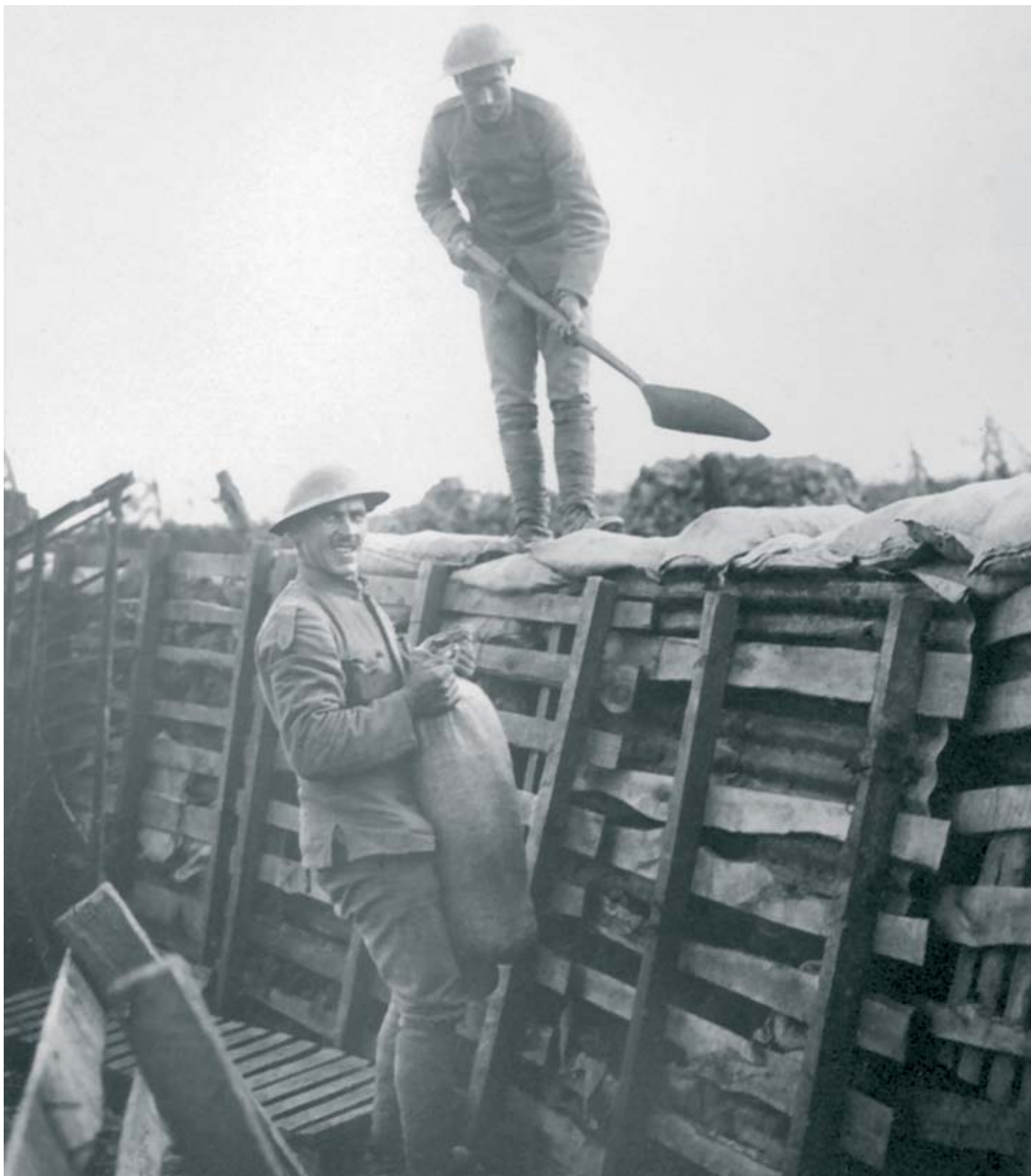
Preparação e melhoramento de trincheiras
