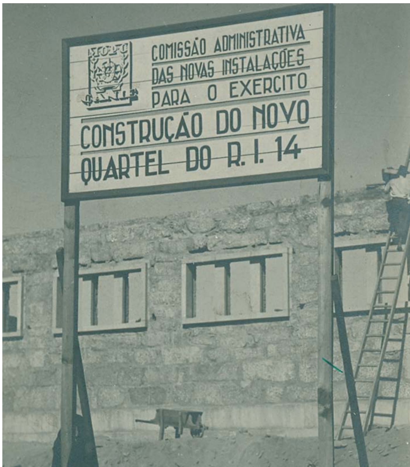
1949-1950 Novo quartel em construção
