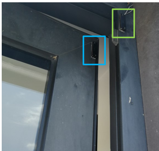
Fig. 5 – Sensor magnético instalado numa das janelas da empresa (a cor azul - Íman; a cor verde - Sensor magnético)
