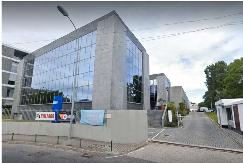
Figura 1.3 – Sede da Dräger Portugal em Carnaxide, Lisboa.
