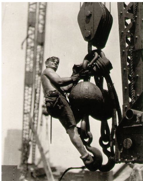
Ilustração 11 - Man on hoisting ball Empire State Building , 1931, Lewis Hine 56
