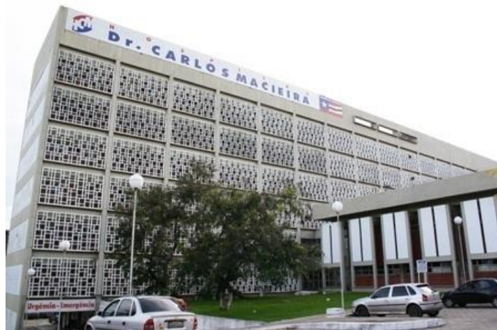
Figura 1 – Fachada do Hospital de Alta Complexidade Carlos Macieira Fonte: Cedido pela Instituição, 2018
