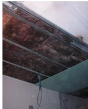
Figura 57 - Estrutura do teto falso
