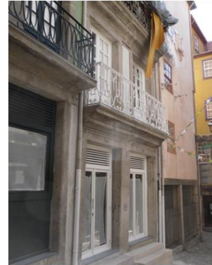
Figura 74 - Fachada principal do antigo edifício da Lavandaria Comunitária
