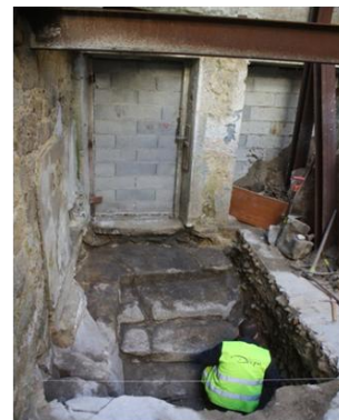
Figura 43 - Largo da Pena Ventosa, nº 23 a 27 - primitivas escadas de acesso ao prédio
