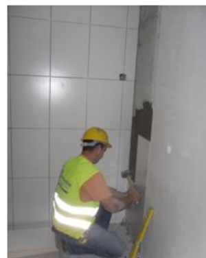
Figura 64 - Assentamento de mosaico cerâmico como acabamento em parede de instalação sanitária
