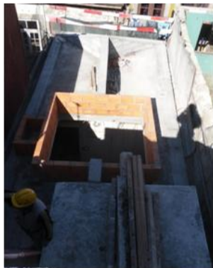
Figura 52 - Estrutura da cobertura
