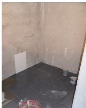
Figura 63 - Assentamento de mosaico cerâmico no pavimento de instalação sanitária
