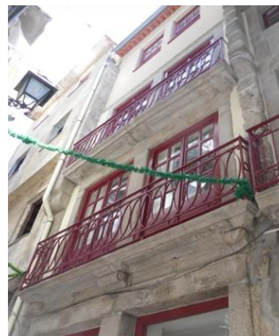
Figura 70 - Fachada principal do antigo edifício devoluto
