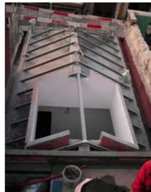
Figura 53 - Estrutura com ripas para fixação do telhado
