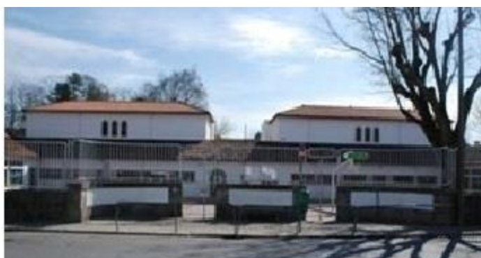
Figura 1: Escola EB 1 de Montebello
