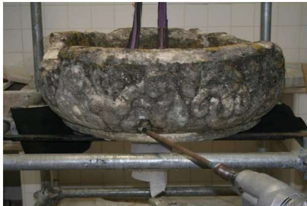
Figura 43. Perfuração a baixa rotação para introdução de espigões de reforço. Foto: autoria do aluno.
