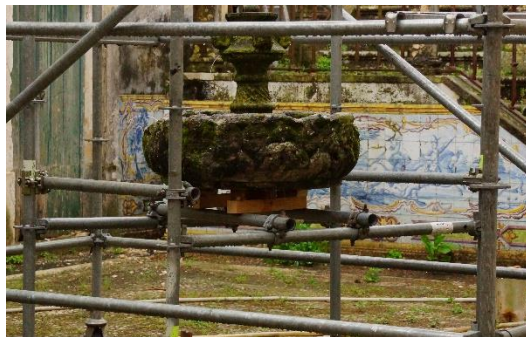
Figura 20. Suspensão do bojo. Registo prévio à sua descida. Foto: autoria do aluno.
