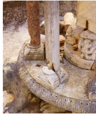
Figura 15. Fraturas ao nível do conjunto de colunas. Foto: autoria do aluno.
