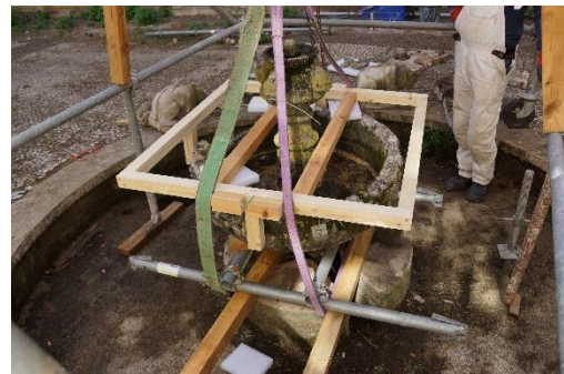
Figura 21. Descida do bojo. Sistema de proteção de forças de compressão por efeito de lingas. Foto: autoria do aluno.
