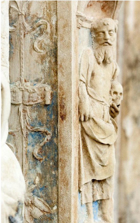
Figura 11. Policromia sobre pilastra. Tons azuis e vestígios de douramento. Foto: Gonçalo Figueiredo, IPT.
