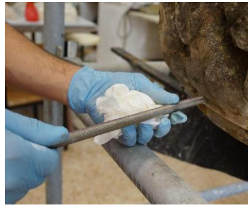
Figura 44. Introdução de espigão de reforço em aço inoxidável. Foto: autoria do aluno.
