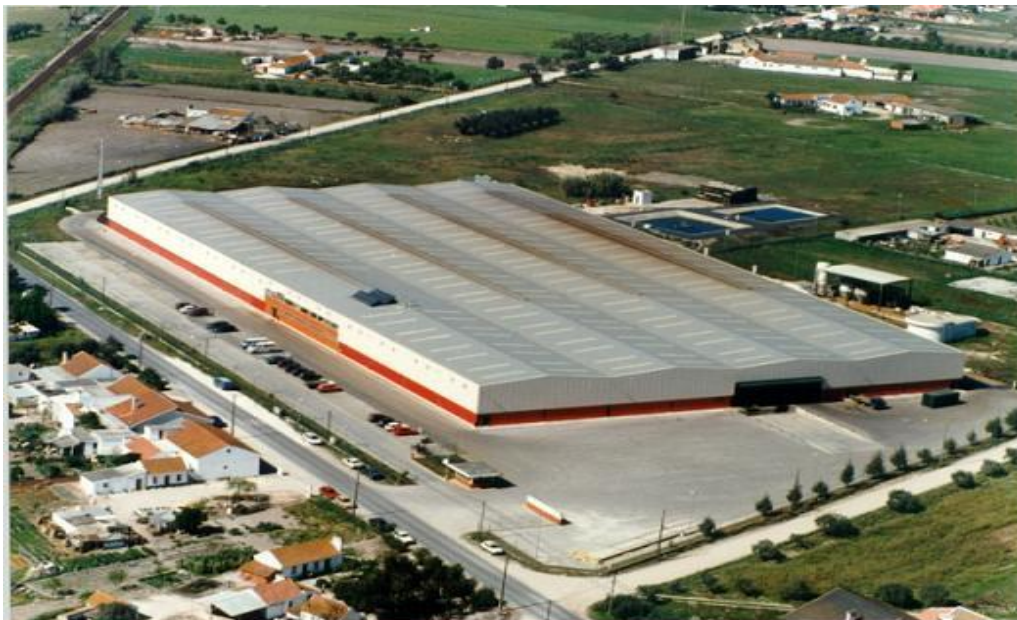
Figura 3 - Vista área das instalações fabris e administrativas da Electro-arco S.A.
