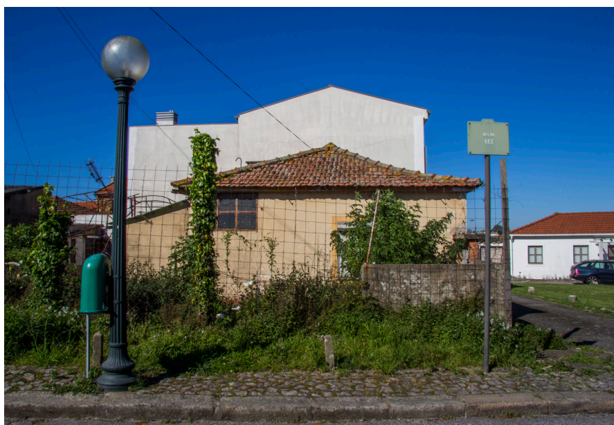
Imagem 55 - Em baixo ao centro: Casa 'A' Tipo I - Vista Frontal
