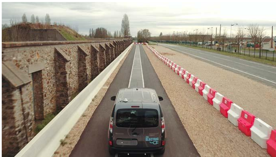
Figura 14 – Estrada de carregamento sem fios dinâmica. [9]
