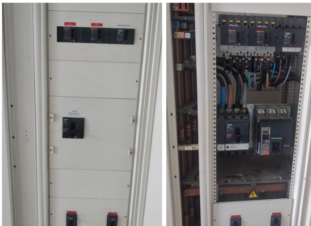
Figura 69. À esquerda o quadro antes da instalação do disjuntor; à direita após instalação de novo disjuntor de 800A para alimentação do chiller
