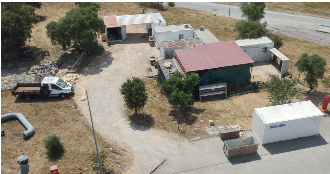
Figura 63. Local do estaleiro com um contentor para reuniões de acompanhamento de obra
