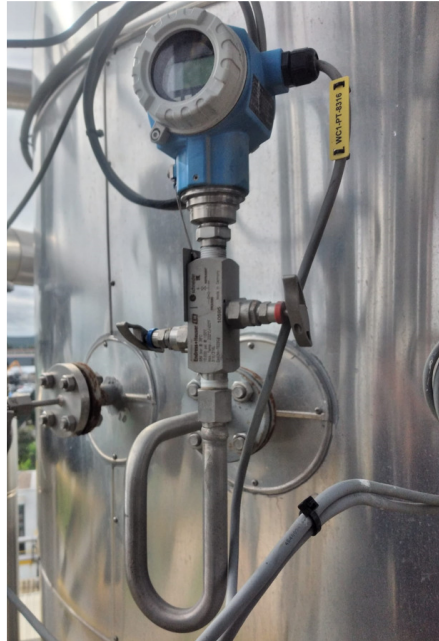
Figura 32. Transmissor de pressão com lira e manifold
