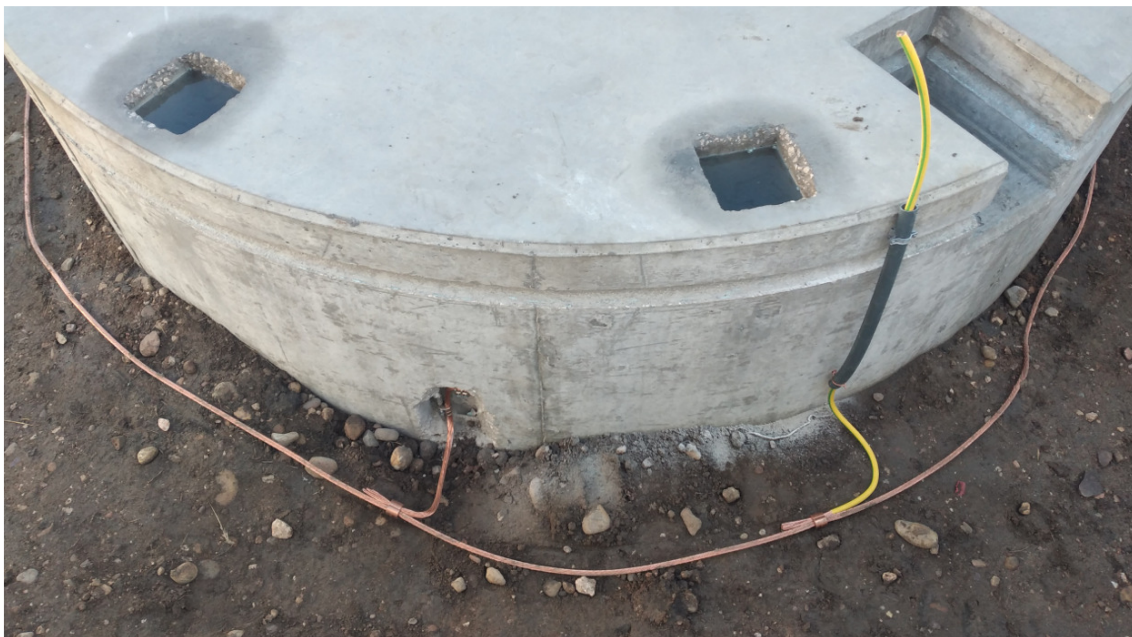
Figura 93. Anel de terras na zona dos tanques
