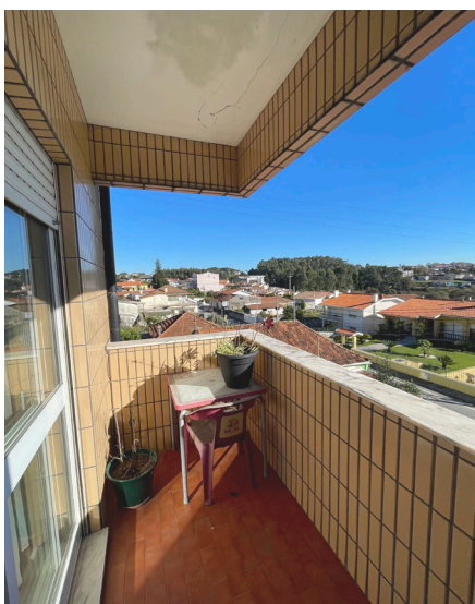
fig.40 Fotografia varanda da sala de estar
