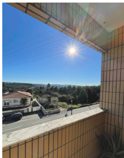
fig.41 Fotografia varanda da sala de estar
