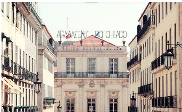
Figura 05 – Fachada Principal dos Armazéns do Chiado 19
