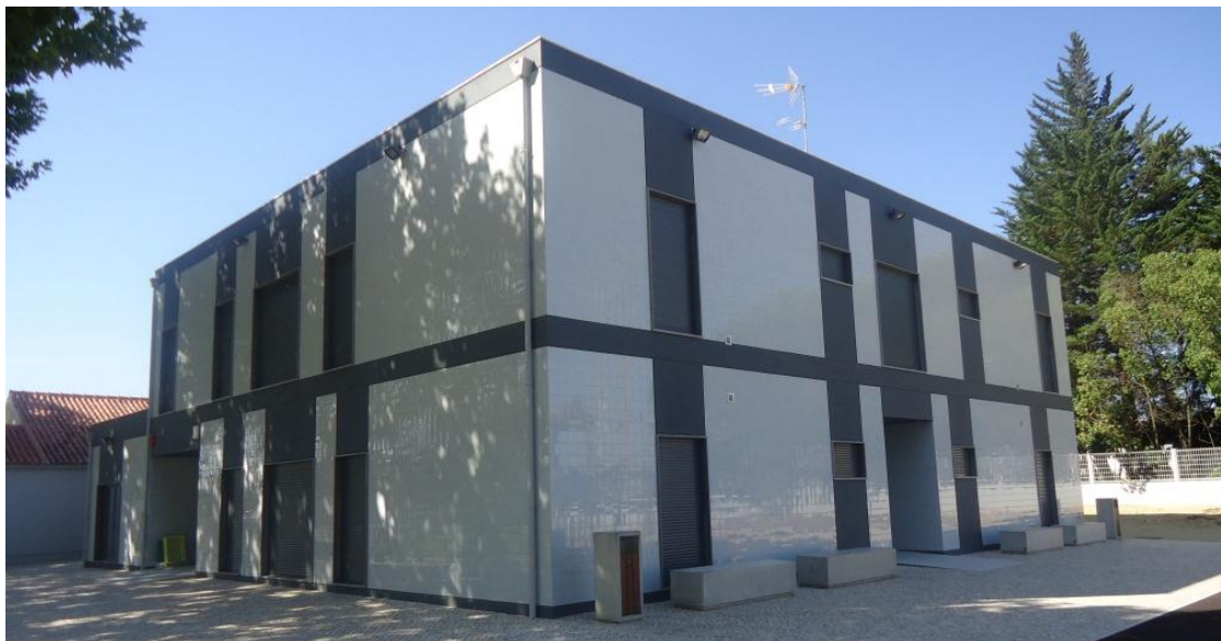
Figura 49 – Exemplo de aspeto do acabamento exterior da escola
