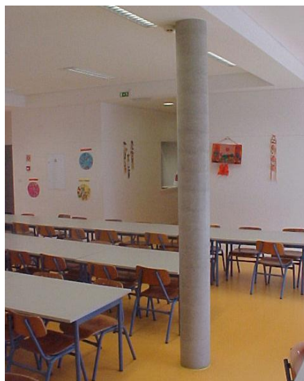
Figura 48 – Pilar localizado na sala de refeições (piso 1 – Rés-do-chão)
