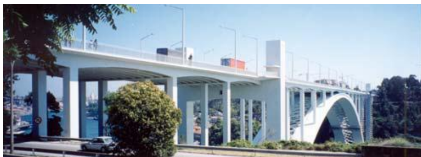
Figura 9 – Ponte da Arrábida. Construção de 1963. [Appleton, J.; s.d.]
