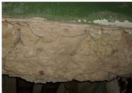
Figura 7 – Exemplo de parede de um Edifício Pombalino no Barreiro.
