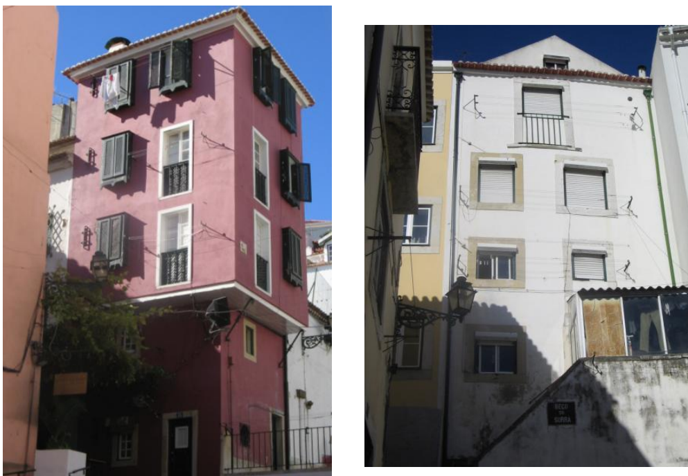
Figura 5 – Exemplos de edifícios Pré-Pombalinos [Santos, M.; 2008]
