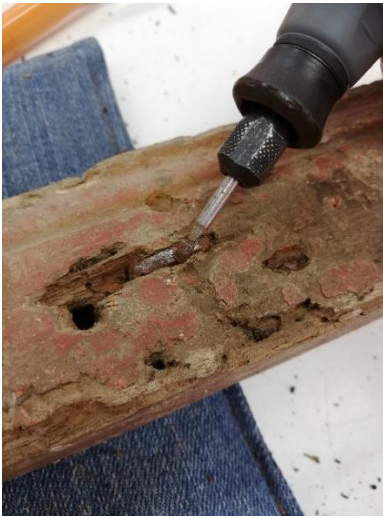
Figura 121 - Desoxidação dos pregos com mini berbequim
