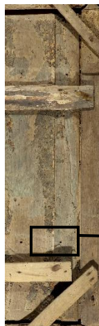
Figura 12 - Área onde é visível parte de uma faixa que poderá ser alburno
