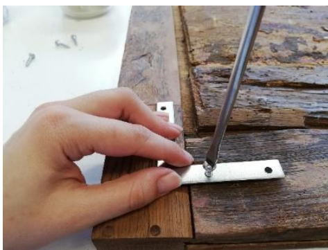
Figura 138 - Aplicação de chapas de reforço
