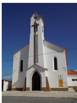
Figura 158 - Exterior da Igreja de Nossa Senhora da Conceição em Geraldês [CF: José Romão, 2016]
