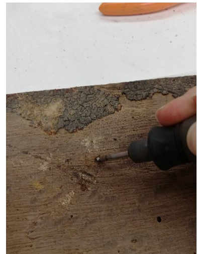
Figura 97 - Desoxidação de prego com mini berbequim com ponta abrasiva
