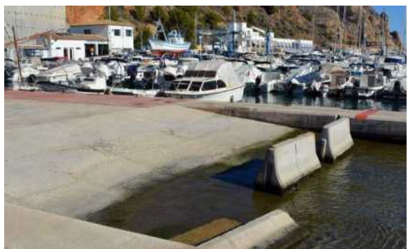
Figura 21: Ejemplo de rampa de varada
