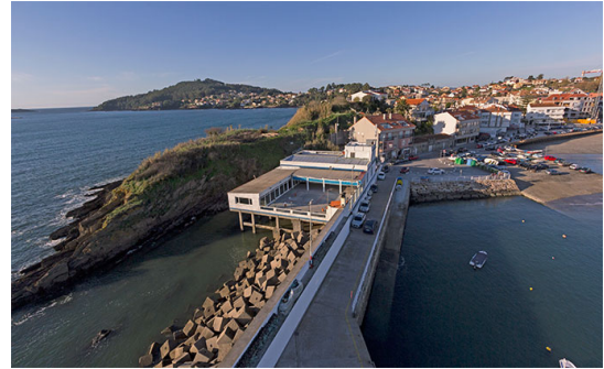
Figura 9: Imagen lateral dique de abrigo de Panxón
