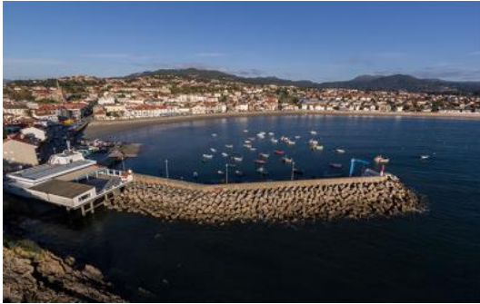
Figura 8: Imagen frontal dique de abrigo de Panxón
