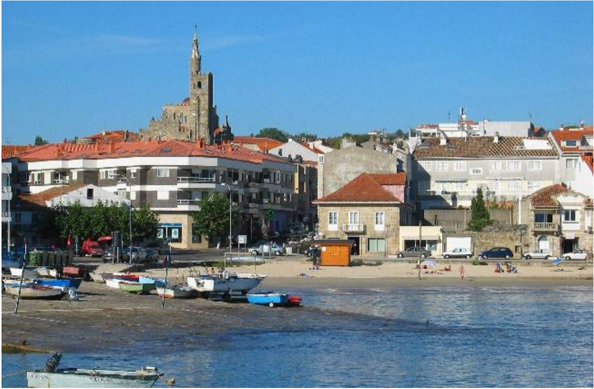
Figura 99: Construcciones en Panxón
