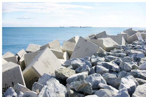
Figura 13: Ejemplo de escolleras en bloque
