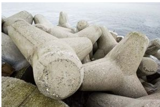
Figura 12: Ejemplo de escolleras triangulares
