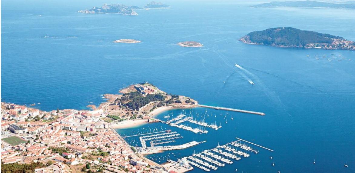
Figura 74: Imagen general de los diques de protección
