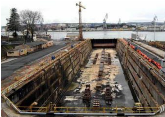
Figura 18: Ejemplo de dique seco
