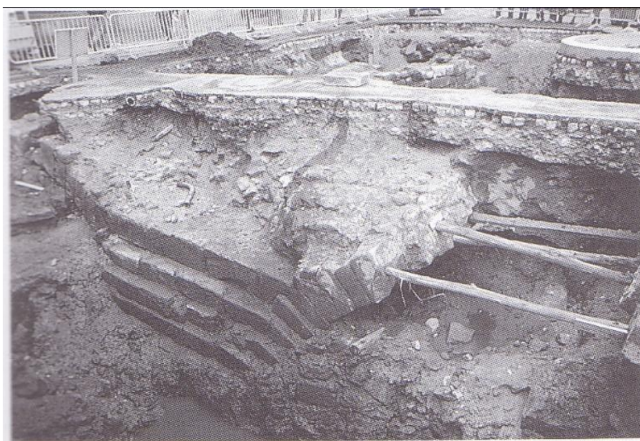
Fig. 8 – Detalle de la excavación de 1988 en el puente de O Burgo. Se aprecian dos arcos medievales del puente original.
