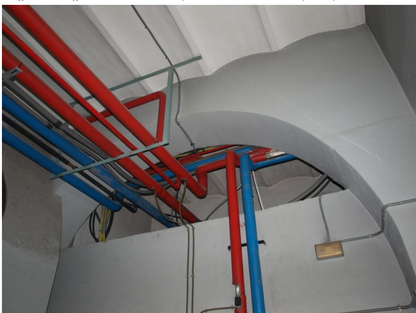
Fig. 90 – Arco original recubierto para la creación de la sala de caldera.
