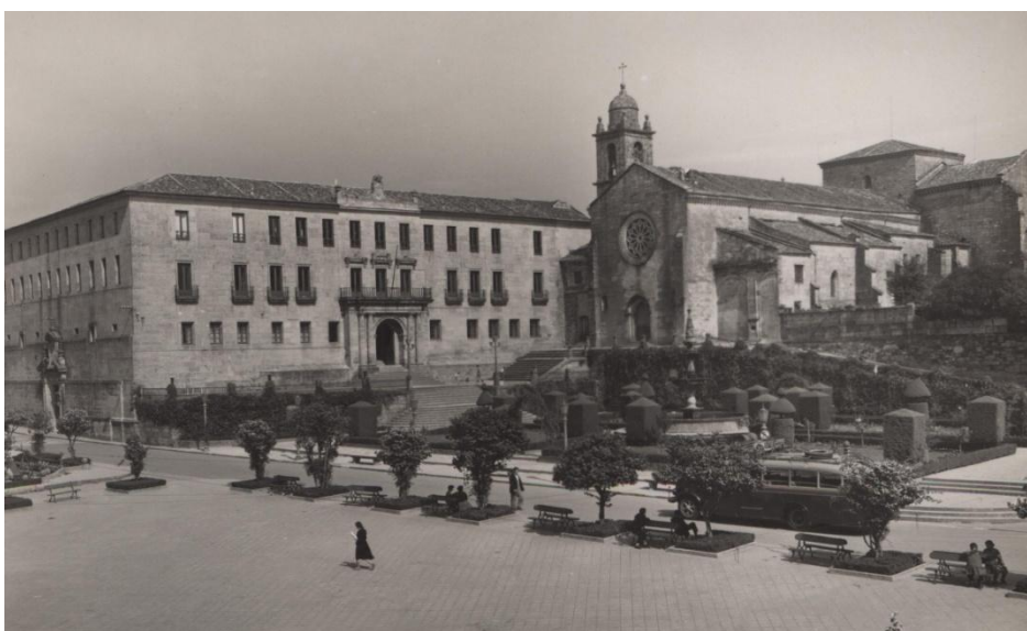
Fig. 43 – Fotografía cedida por el museo de Pontevedra en la que se aprecia el monasterio de San Francisco.
