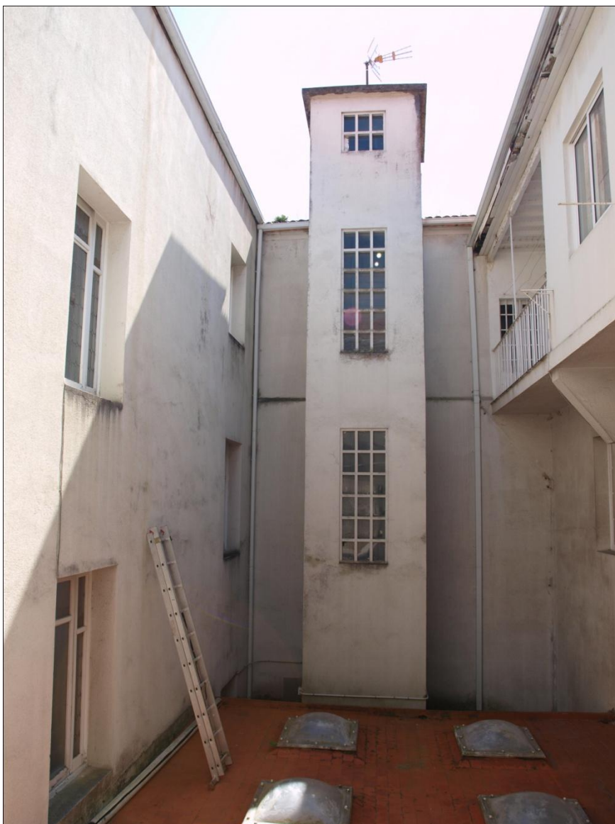
Fig. 91 – Fotografía del estado actual de los patios
