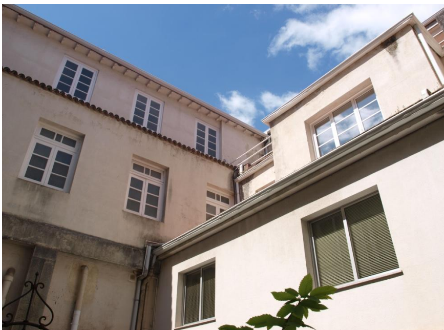
Fig. 92 – Fotografía del estado actual de los patios
