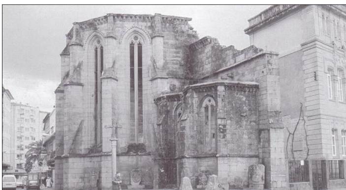
Fig. 12 – Ábsides de la iglesia convento de Santo Domingo. Instalados con anterioridad en As Corbaceiras, los dominicos se trasladan e inician su construcción en 1380, intentando competir en monumentalidad con la iglesia de los franciscanos.
