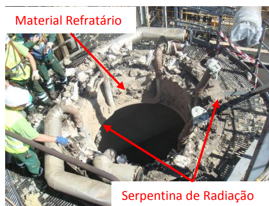
Figura 4.1.15 -Serpentina de Radiação após Remoção do Krummer
