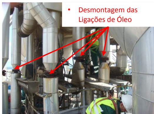
Figura 4.1.2 - Desmontagem das Ligações de Óleo Térmico
