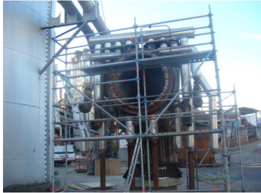
Figura 4.1.22 - Trabalhos de Limpeza e Inspeção Krummer
