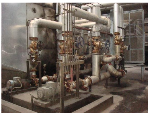
Figura 3.3.18 - Bateria de óleo para aquecimento do ar do secador da camada externa
