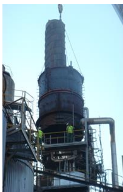
Figura 4.1.30 - Montagem da Serpentina
