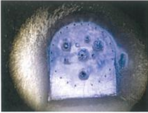
Figura 4.6.8 - Vista Geral da Condição Interior da Câmara de Combustão (ISQ, 2014)
