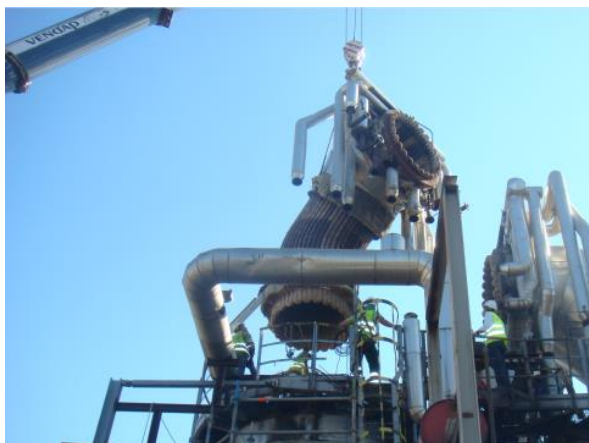
Figura 4.1.33 - Montagem do Krummer
