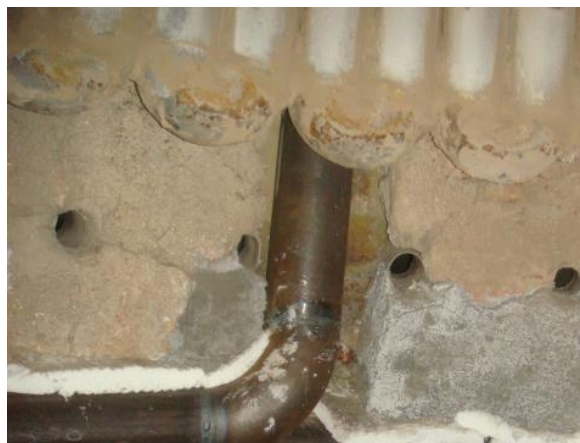
Figura 4.1.34 - Reparação de Material Refratário
