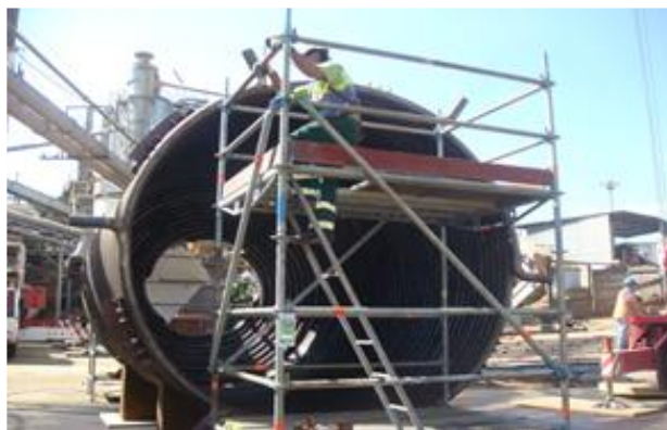
Figura 4.1.25 - Soldaduras das Tubagens de Entrada de Óleo (Inferiores)
