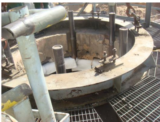
Figura 4.1.37 - Isolamento da Serpentina
