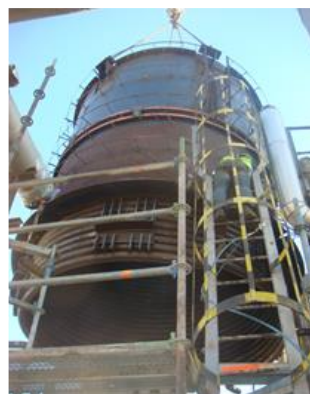
Figura 4.1.31 - Montagem da Serpentina
