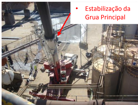
Figura 4.1.10 - Estabilização da Grua Principal
