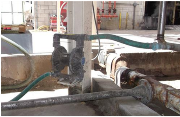
Figura 4.8.3 - Instalação antes da Intervenção
