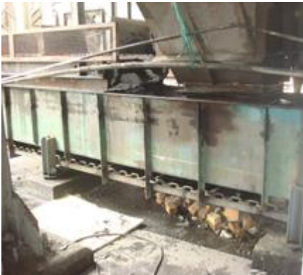
Figura 4.7.2 - Transportador Antes da Intervenção
