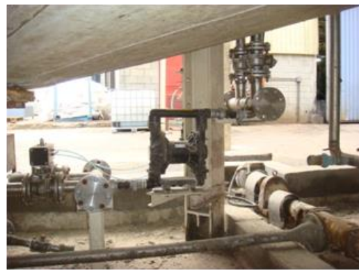
Figura 4.8.4 - Instalação Depois da Intervenção
