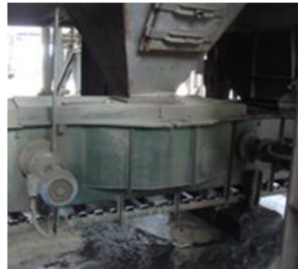
Figura 4.7.3 - Transportador Após a Intervenção
