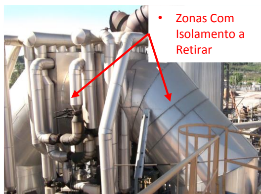
Figura 4.1.8 - Remoção de Isolamento do Krummer
