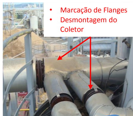
Figura 4.1.3 - Desmontagem e Marcação das Ligações de Óleo Térmico
