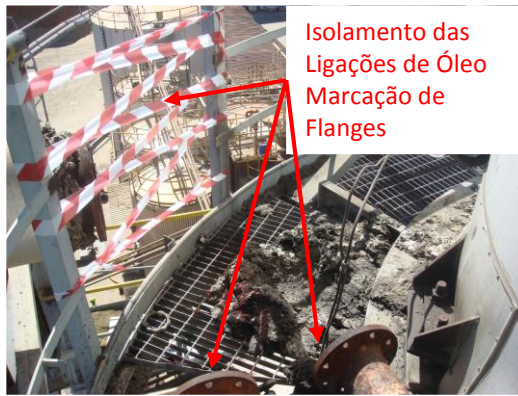
Figura 4.1.4 - Desmontagem do Coletor
