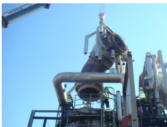
Figura 4.1.33 – Montagem do Krummer
