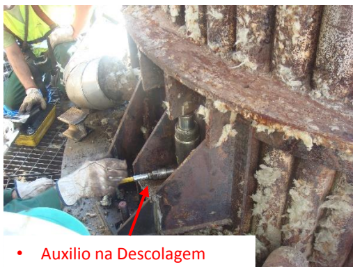
Figura 4.1.12 - Descolagem dos Apoios
