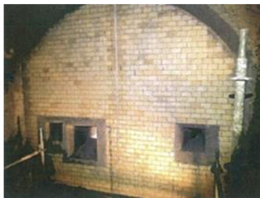
Figura 4.6.3 - Parede Frontal Após Beneficiação
