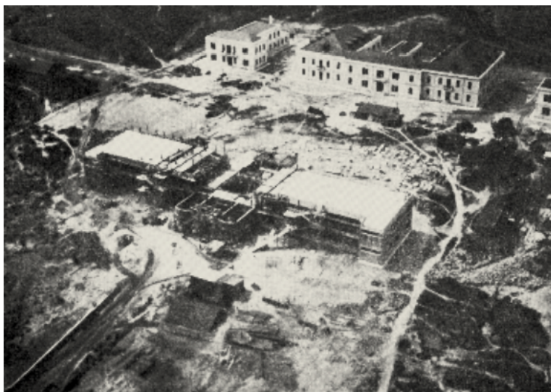
FIGURA 2.5: Instalações da Escola Naval em construção, Alfeite. (Salgado, 2013)
