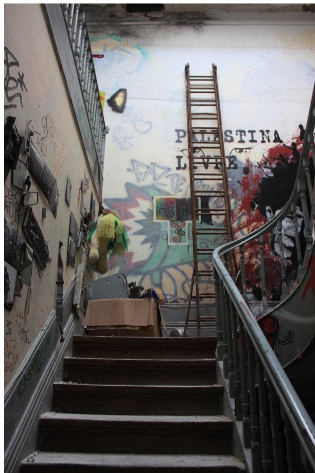
IMAGEM 30 Fotografia das escadas no último piso - galerias.
