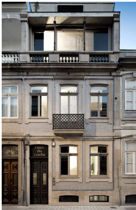
IMAGEM 57 Fotografia do alçado do edifício com projeto do atelier Pedra Líquida.
