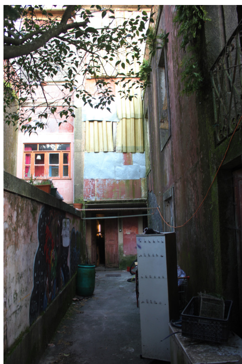
IMAGEM 24 Fotografia da fachada tardoz.
