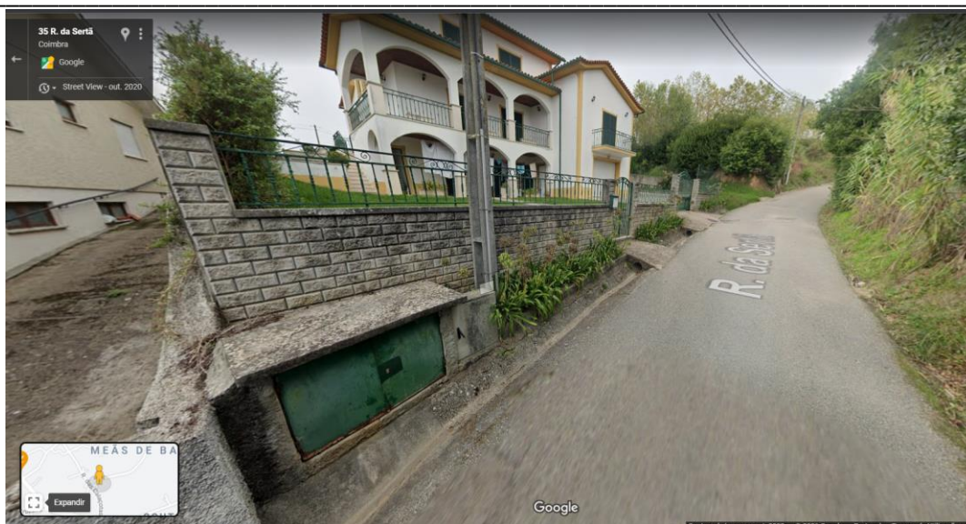
Figura 79: Início da Rua Sertã, local de instalação do hidropressor de Meãs
