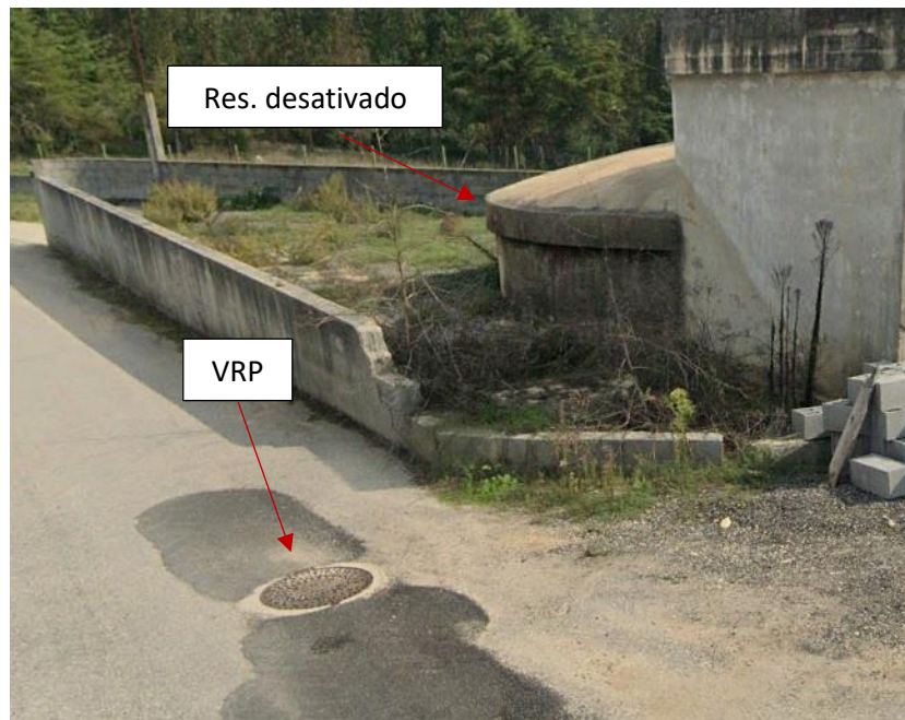
Figura 82: Local de instalação da VRP – Boleta na via, próximo a um reservatório desativado (Imagem Google Earth)
