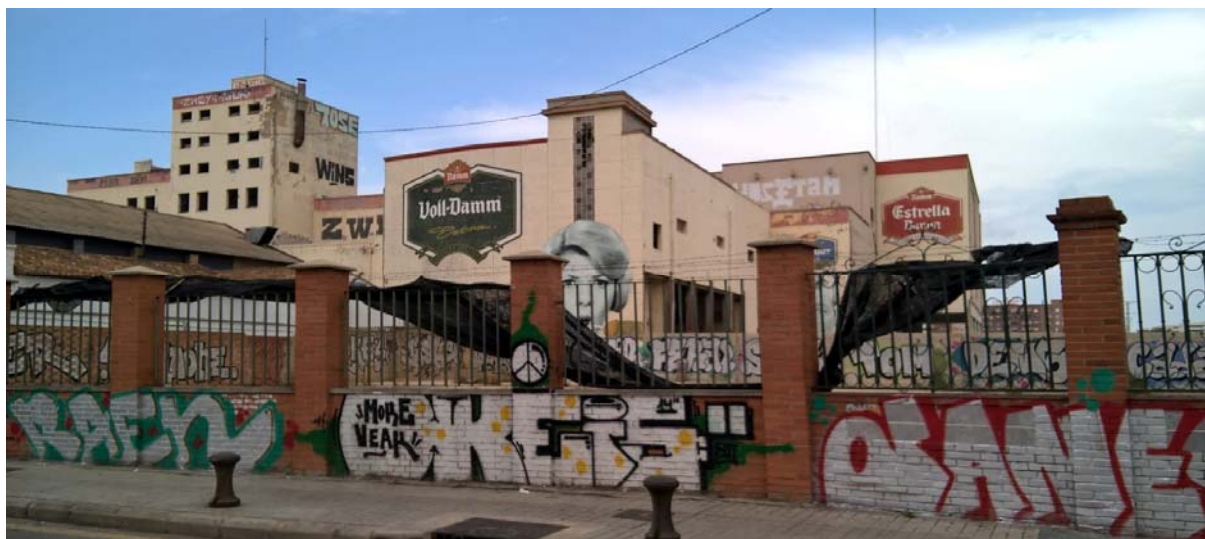
005. Fábrica de cervezas El Turia, ya derribada.
