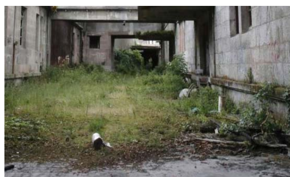
248. Solera de hormigón armado y adoquinado
