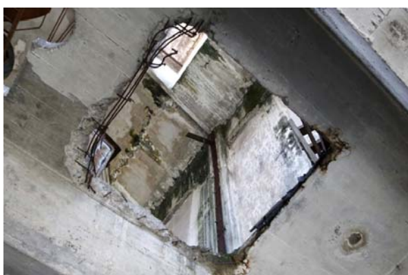
244. Detalle de losa maciza
