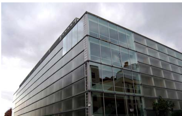
109. Fachada mixta de Uglass y panel de vidrio
