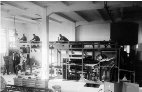
182. Operarios en montaje de horno
