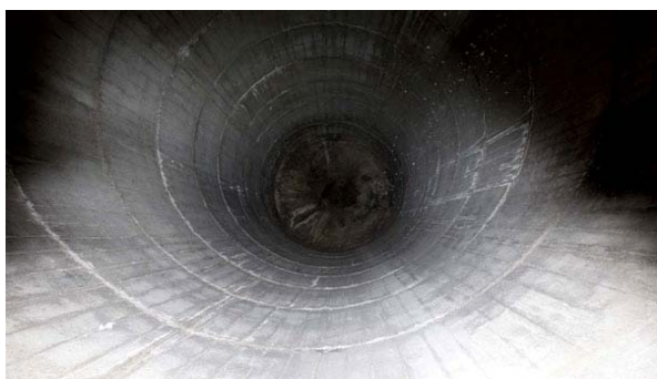
241. Vista interior estructura silos
