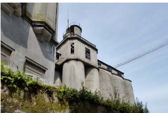
228. Muro perimetral y silos en calle Santiago
