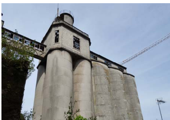
256. Muros de H.A. en silos
