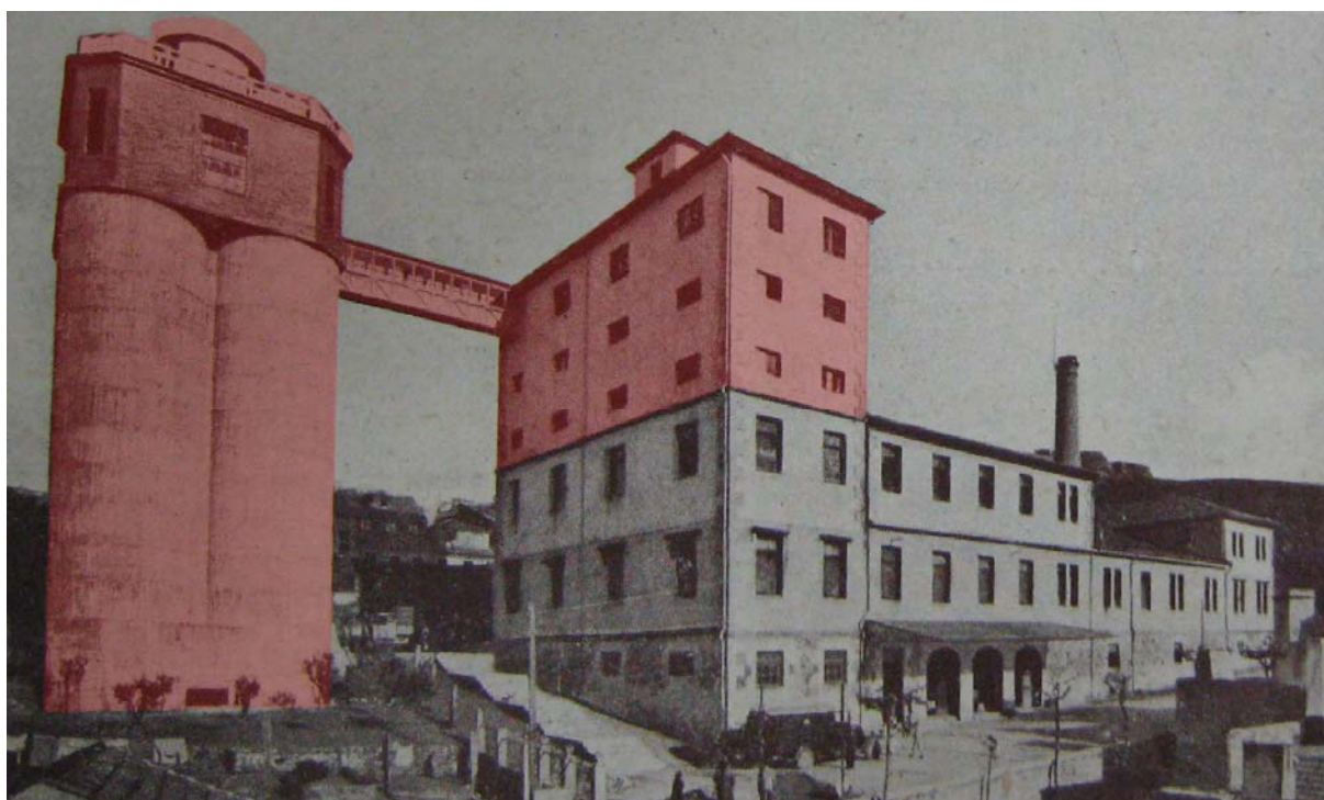
164. Vista fachadas norte y oeste, con ampliación fábrica de harinas y 4 silos
