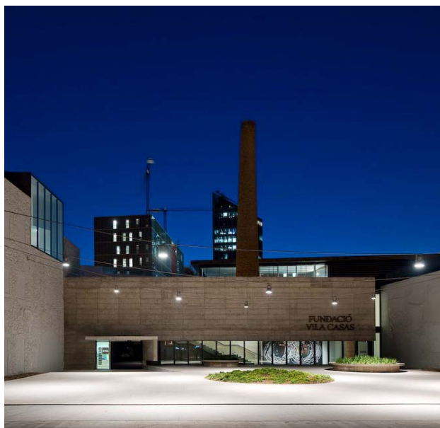
085. Plaza central del complejo (hormigón blanco)
