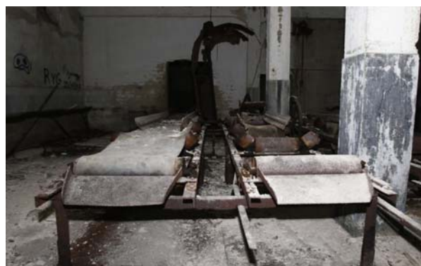
235. Maquinaria en planta baja fábrica de pan
