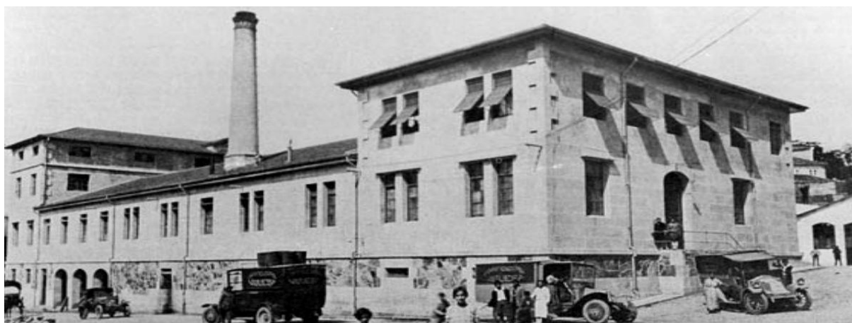
163. Vista de la fachada sur y oeste del edificio original de la Panificadora
