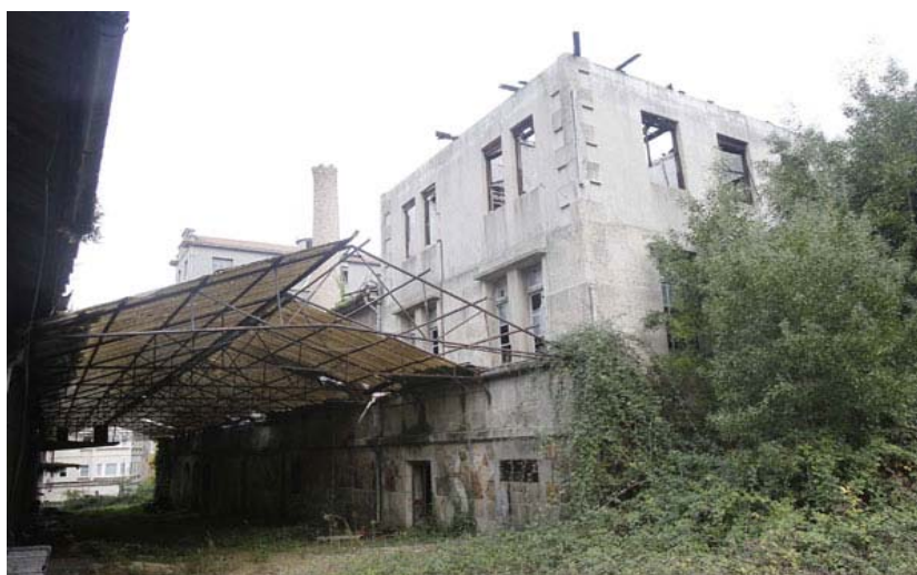
219. Edificio de oficinas parcialmente oculto bajo la vegetación
