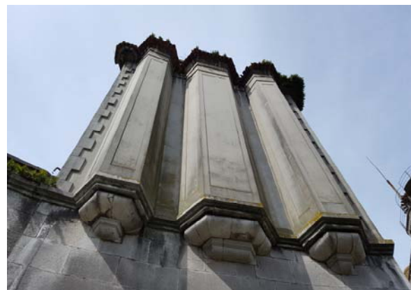
257. Muros de H.A. en silos fachada este
