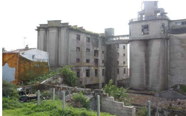
223. Edificio principal y silos desde la plaza del Rey
