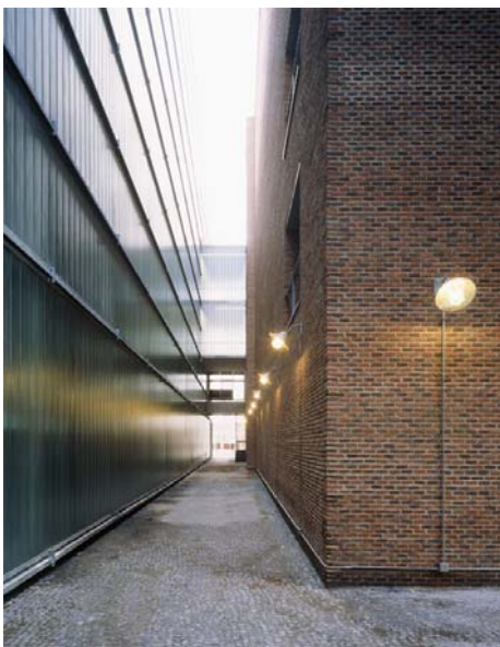
124. Eje longitudinal Este
