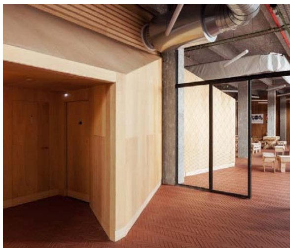
144. Pavimento zigzag en baldosín cerámico
