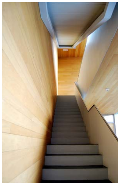
111. Paramentos hormigón visto 112. Revestimiento chapa roble 113. Revestimiento panel aluminio
