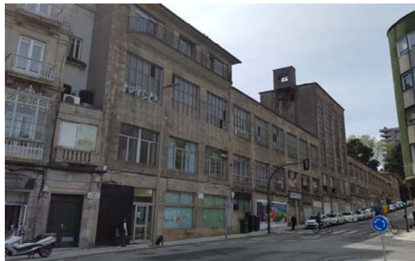
225. Fachada fábrica de harinas en calle Falperra
