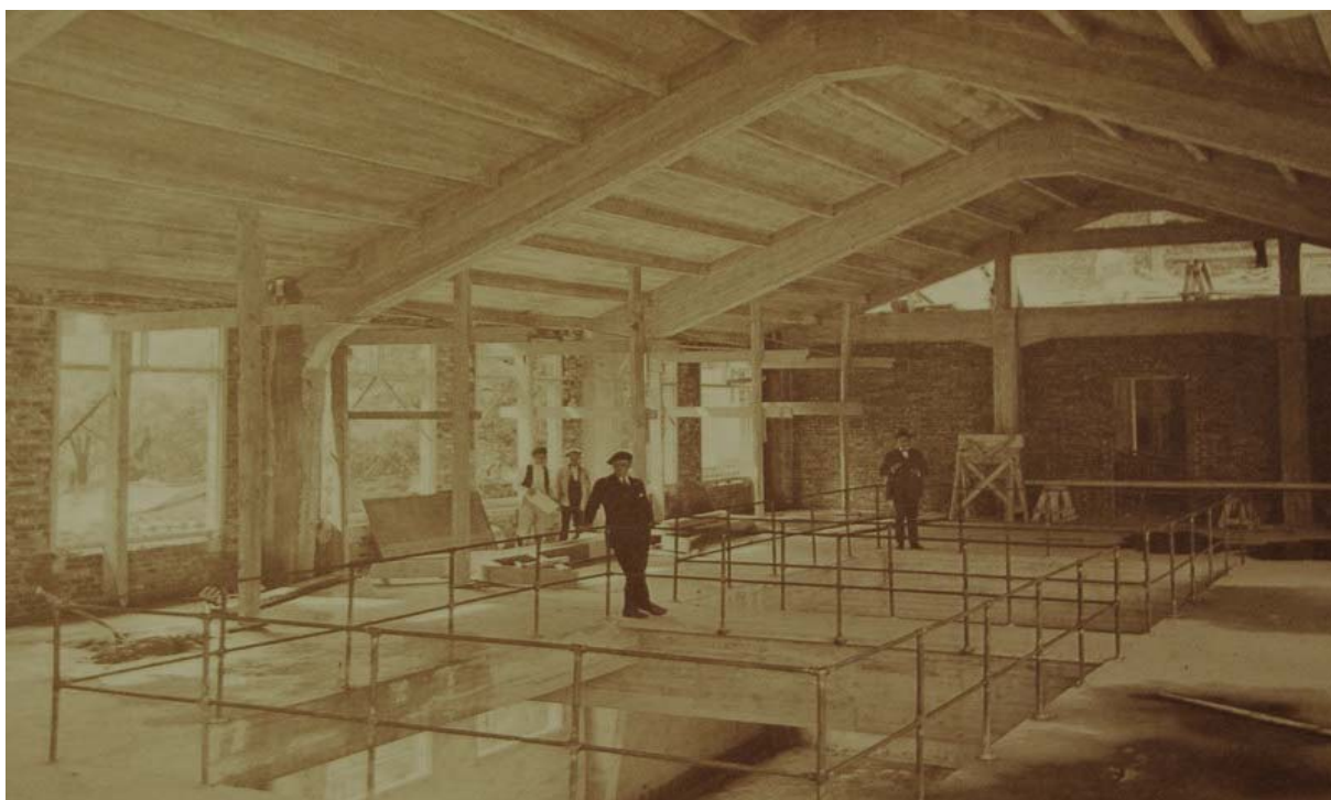
130. Imagen del período de construcción nuevo edificio
