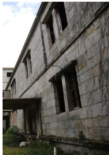
253. Calle interior de la fábrica
