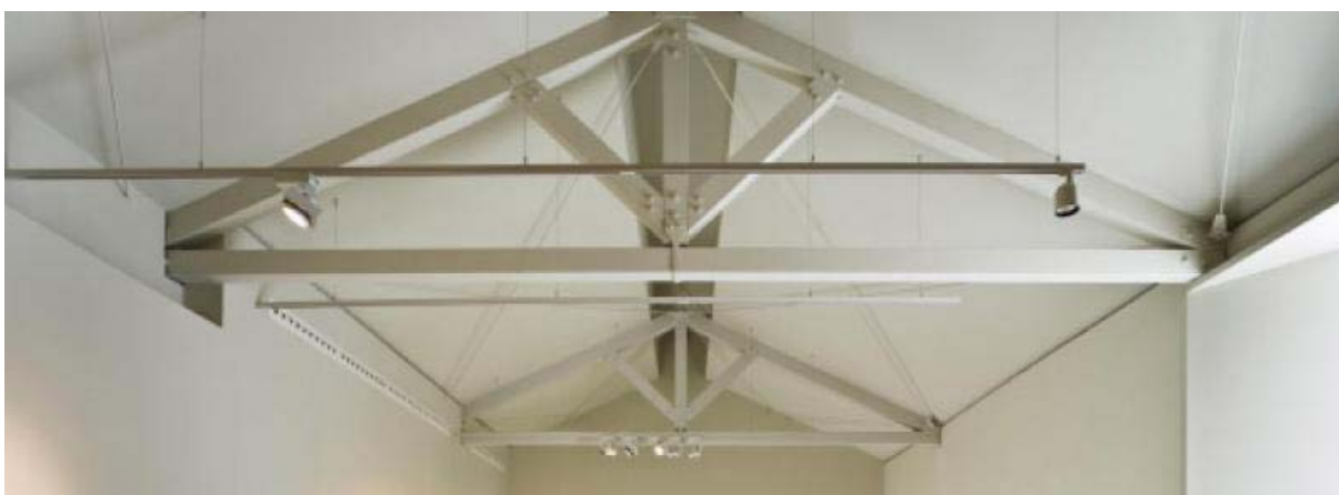
086. Vista de cerchas de cubierta
