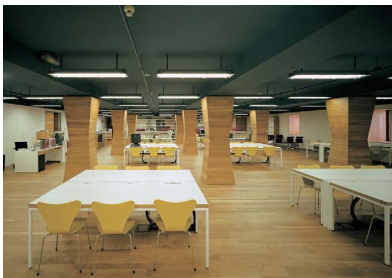
114. Pavimento de tarima flotante con acabado roble
