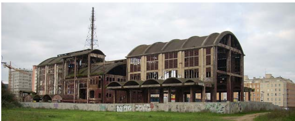
004. Antigua fábrica Cros en O Burgo (hormigón armado)
