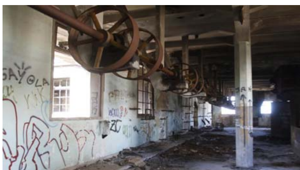
239. Estructura en buen estado
