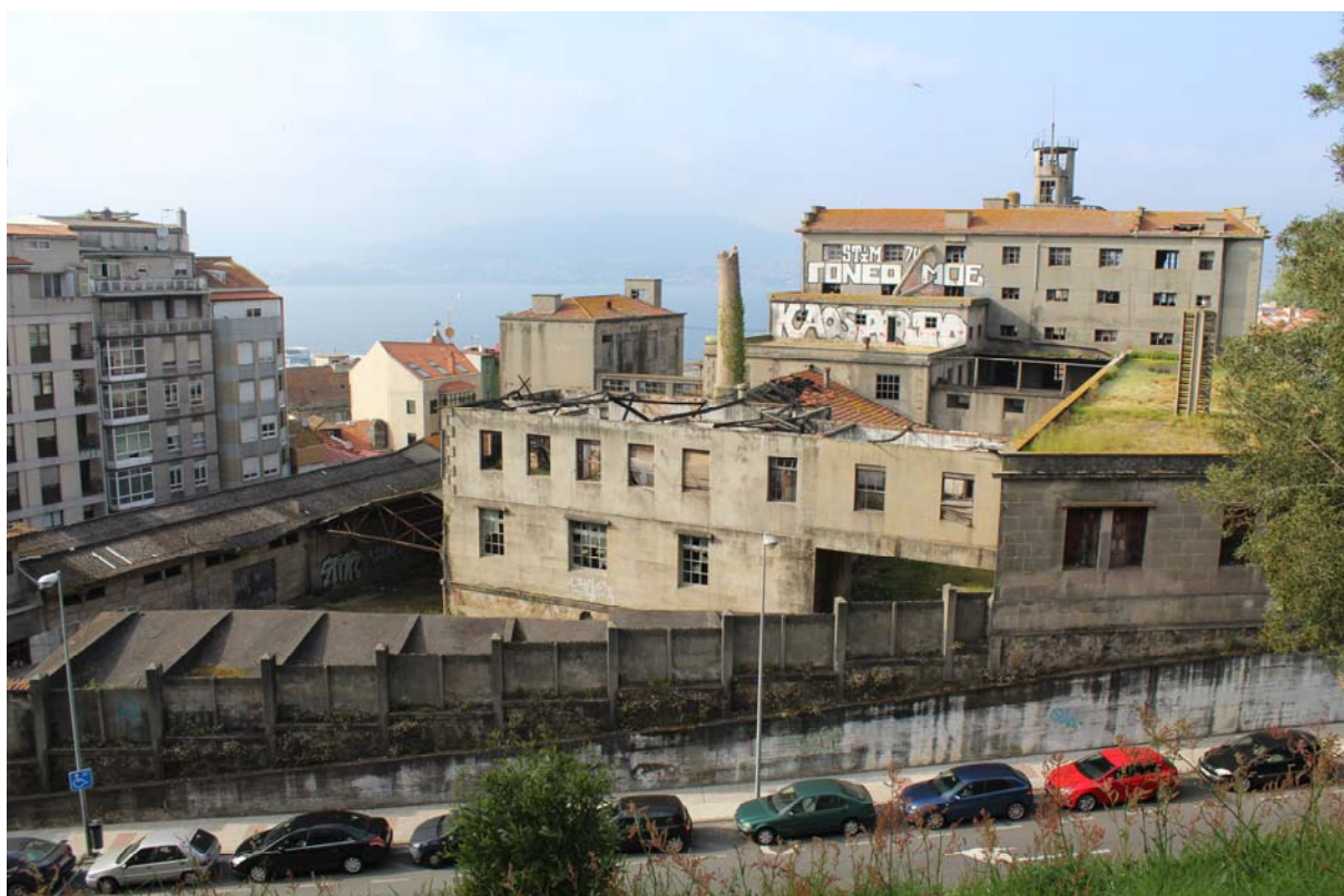
187. Vista general de La Panificadora desde la Avenida de Camelias
