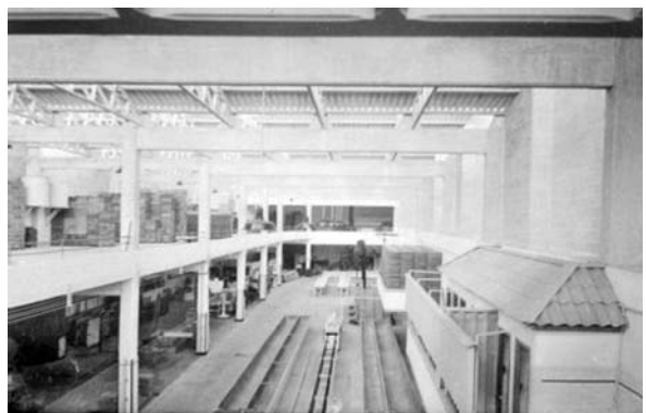
181. Vista interior fábrica de pan
