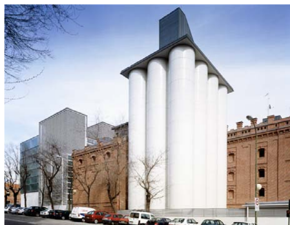
117. Silos de hormigón con revestimiento metálico
