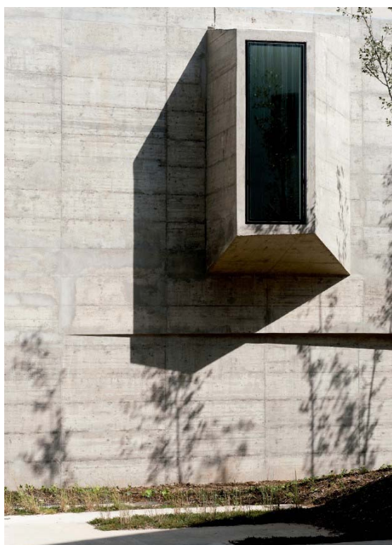
079. Muro exterior estructural hormigón armado
