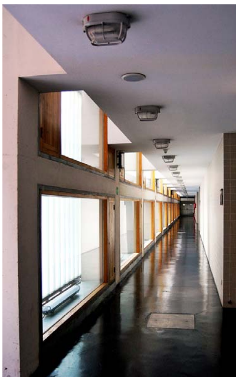
106. Sistema de vigas y pilares a la vista en pasillo interior
