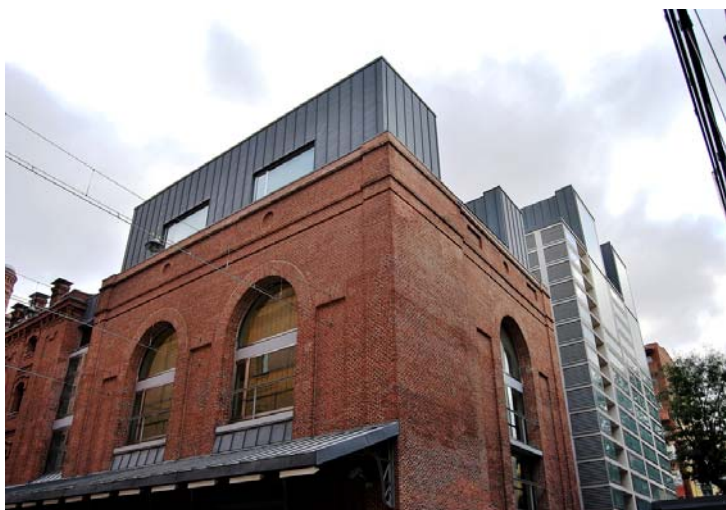
120. Alineación de fachadas en calle norte del complejo
