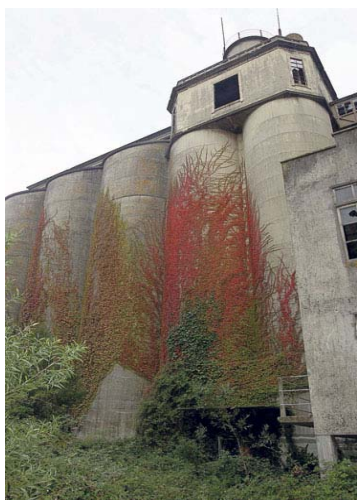
218. Silos tupidos de vegetación
