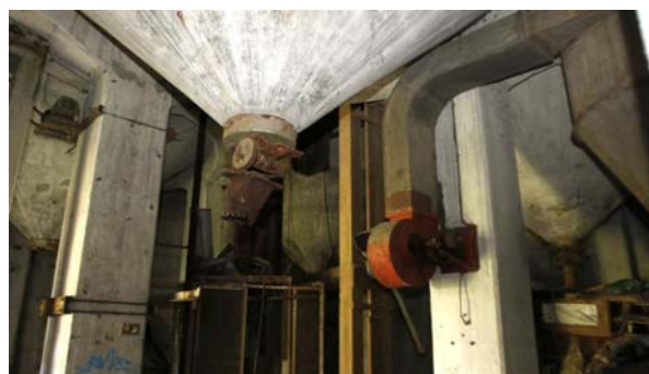
242. Vista interior estructura soporte silos
