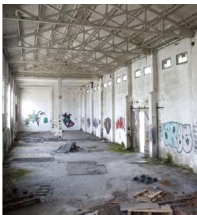
263. Dos aguas estructura H.A
