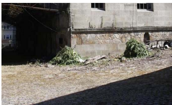
247. Suelo adoquinado (adoquín 20x10x20)
