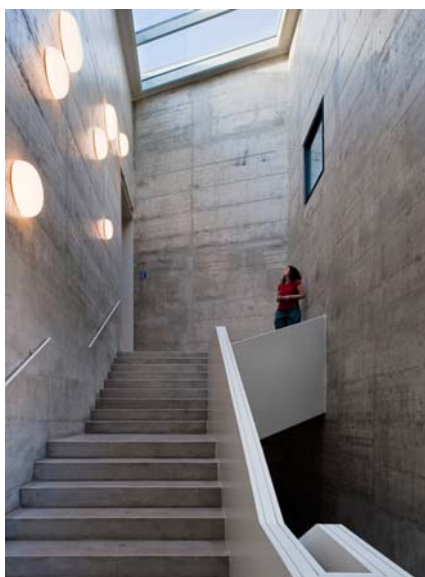
081. Muro H.A. en núcleo escaleras
