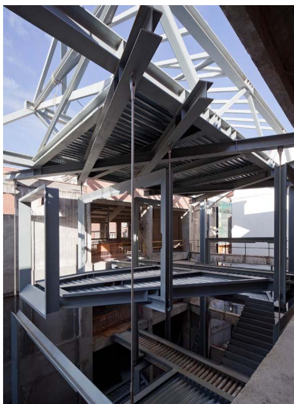
138. Estructura, y forjados en chapa colaborante
