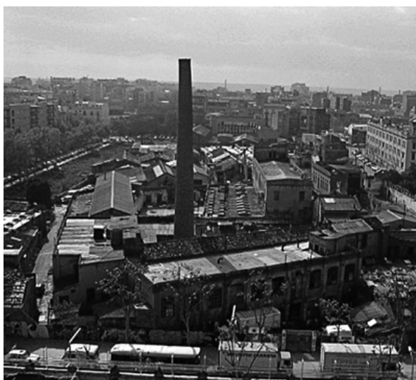
072. Can Framis completo (antes del vaciado)
