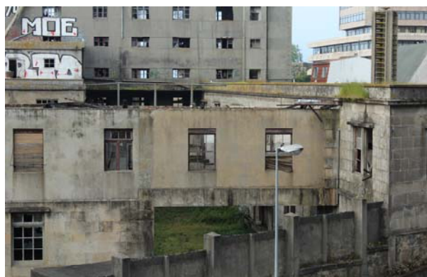
229. Puente entre oficinas y fábrica de harinas
