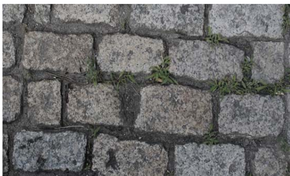
249. Detalle del adoquinado
