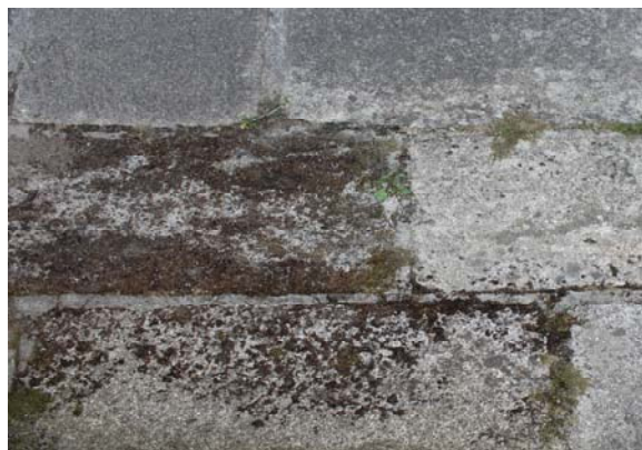
255. Muro granítico a vía privada
