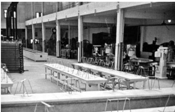
180. Vista interior fábrica de pan
