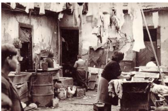
024. Insalubridad en patio de vivienda obrera
