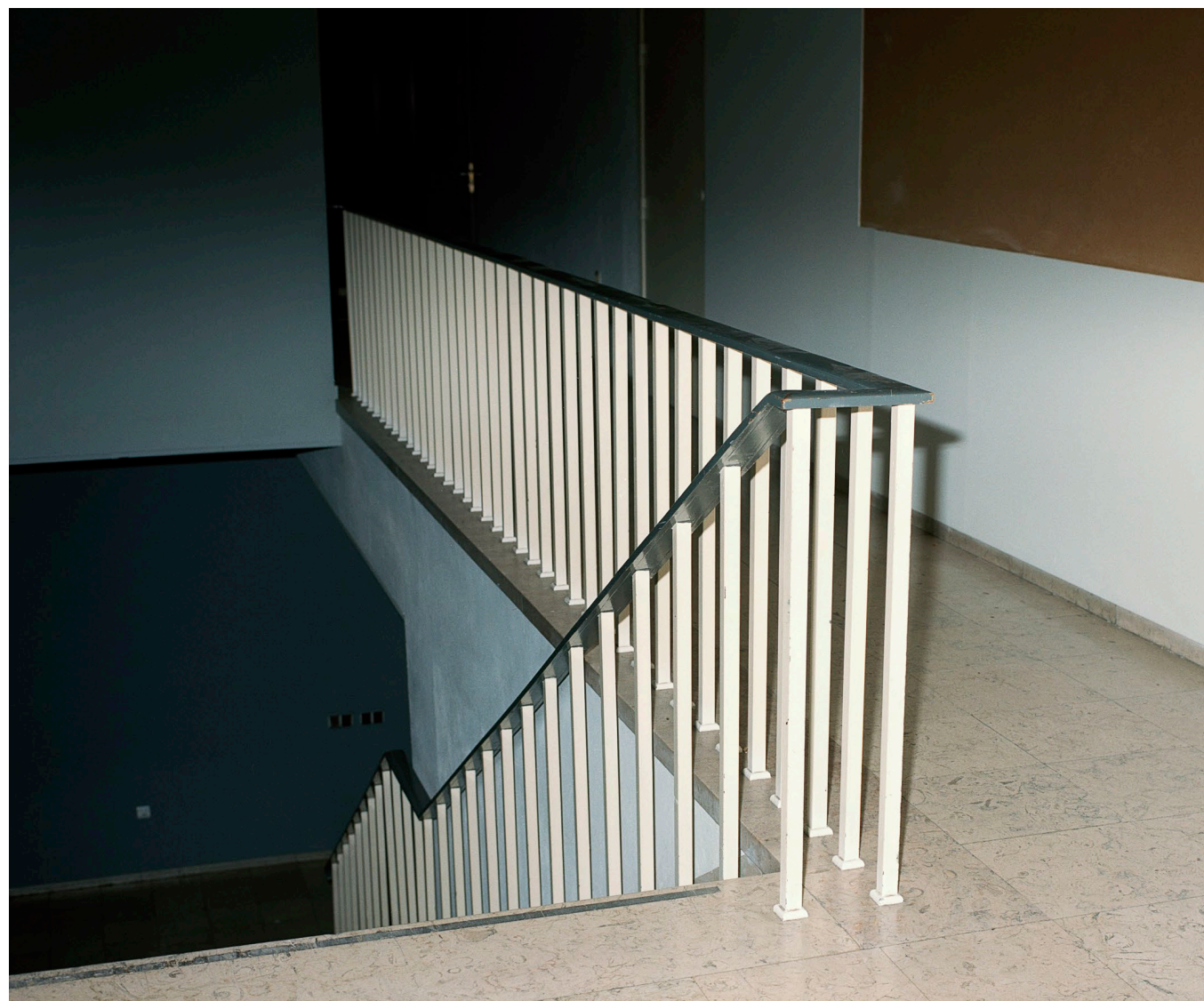
FIG.32 Interior do teatro antes das obras, André Cepeda.
