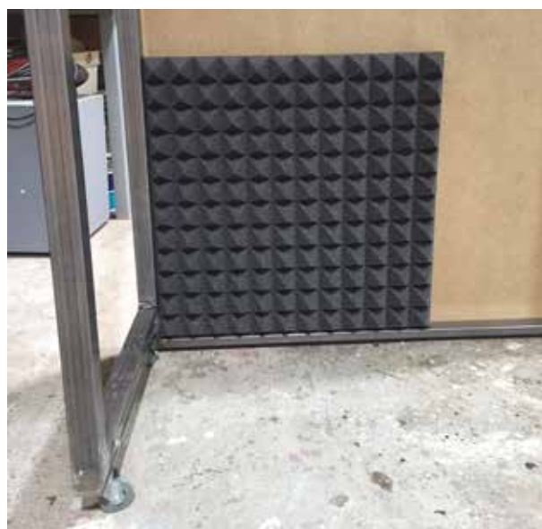
69. Colagem placas de espuma acústica
