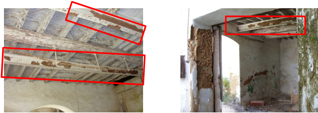
Figura 99 – Perfis metálicos colocados numa intervenção anterior, Sara Lopes (2013)
