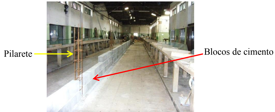
Figura 54 – Construção de parede divisória, Sara Lopes (2013)
