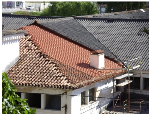
Figura 71 – Aspeto da cobertura que foi substituída, Sara Lopes (2013)
