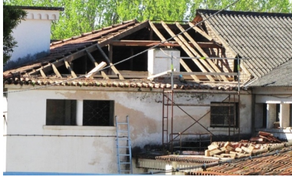
Figura 70 – Remoção das peças em madeira degradadas da estrutura da cobertura. [27]
