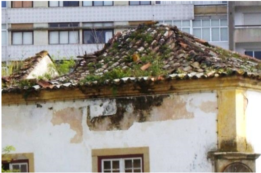
Figura 84 – Cobertura da Casa do Pego, Sara Lopes (2013)
