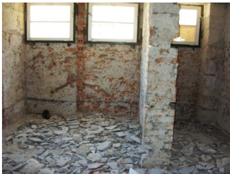
Figura 36 – Demolição de parede, Sara Lopes (2013)
