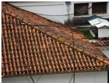
Figura 69 – Aspeto da cobertura cerâmica, Sara Lopes (2013)
