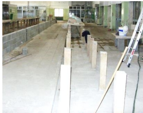
Figura 53 – Colocação de bancadas na zona central, Sara Lopes (2013)
