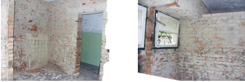
Figura 38 – Picagem de reboco, Sara Lopes (2013)
