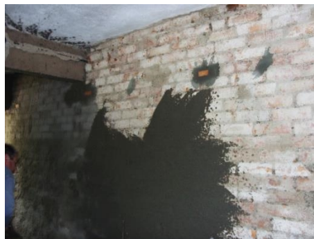
Figura 41 – Aplicação do chapisco, Sara Lopes (2013)
