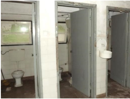
Figura 34 – Aspeto das i.s. antes da obra, Sara Lopes (2013)
