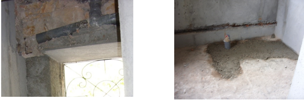
Figura 45 – Aplicação da tubagem em PVC e enchimento de roços, Sara Lopes (2013)
