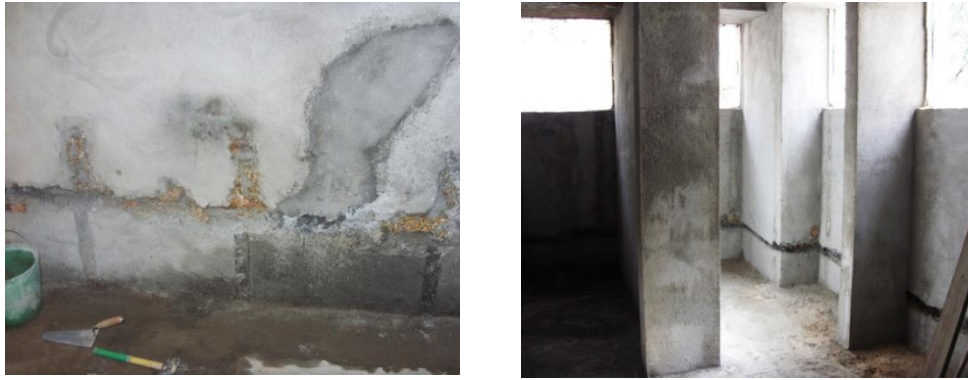
Figura 43 – Paredes rebocadas e com os roços abertos, Sara Lopes (2013)
