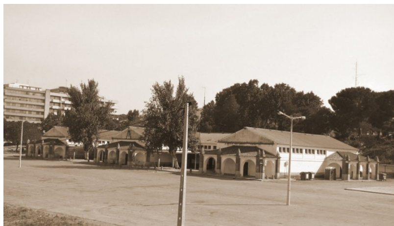
Figura 17 – Aspeto exterior do edifício [9]
