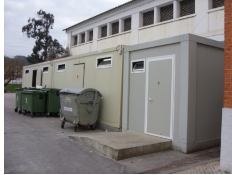
Figura 25 – Instalações sanitárias provisórias, Sara Lopes (2013)
