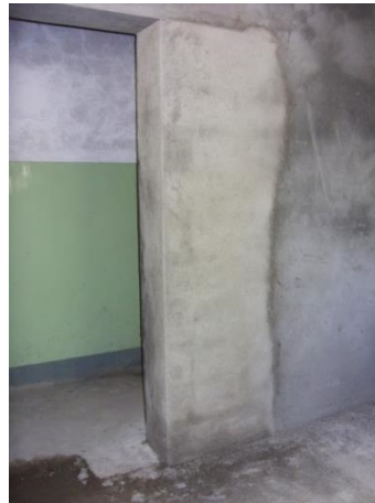
Figura 44 – Parede construída posteriormente, Sara Lopes (2013)
