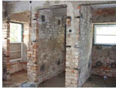
Figura 35 – Aspeto das i.s. após o início das obras, Sara Lopes (2013)
