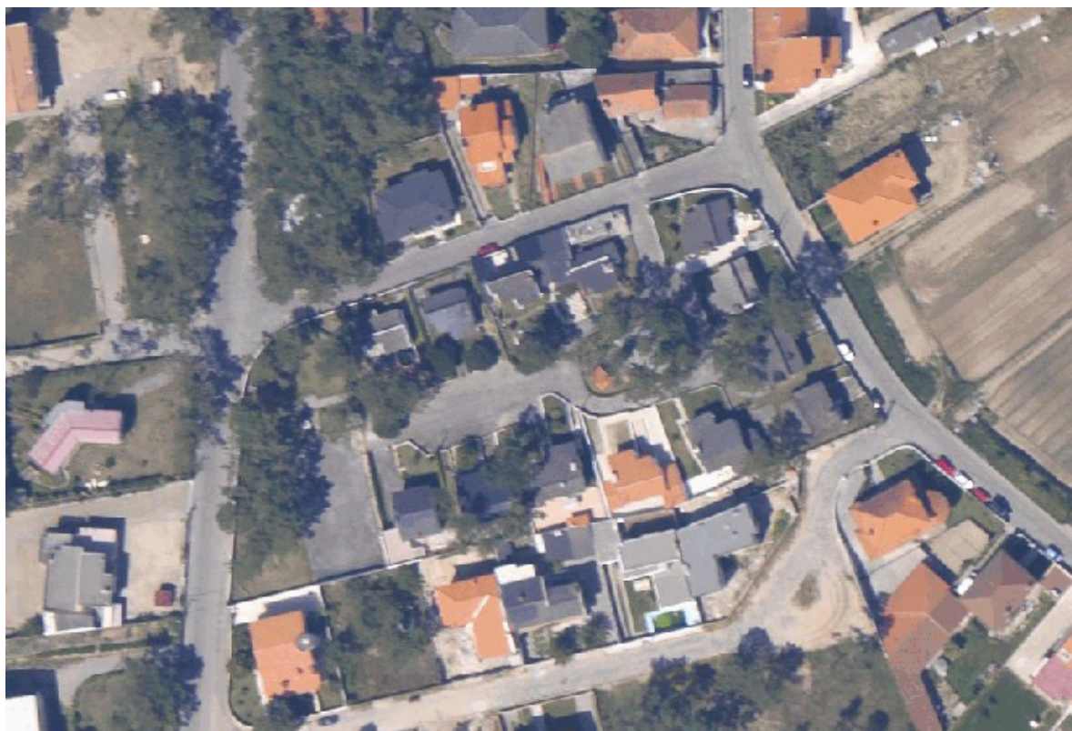
Fig. 42 - Loteamento urbano, em Areia, no extremo sul da freguesia de Apúlia. C.M. de Esposende, aerofotomapa do concelho, voo 2008.
