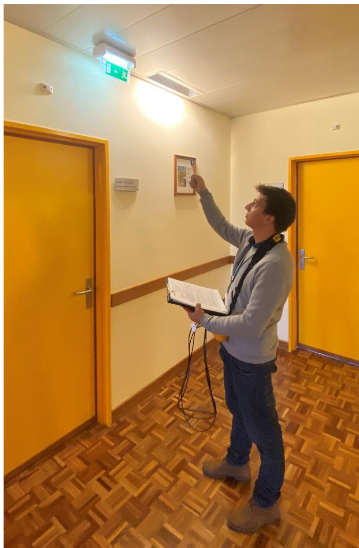
Figura 5.41 - Verificação iluminação de emergência
