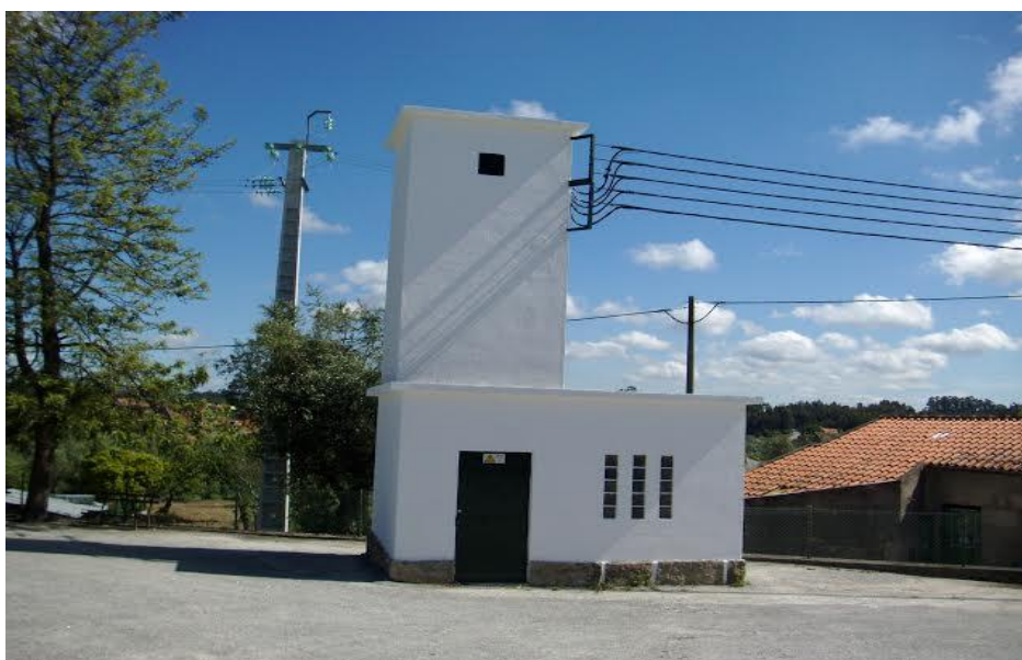
Figura 3.4 - Posto de Transformação – Tipo CA
