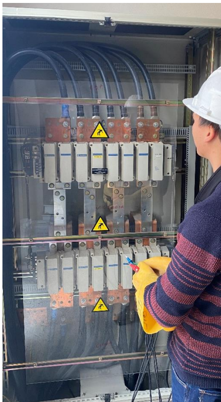
Figura 5.33 - Quadro transferência
