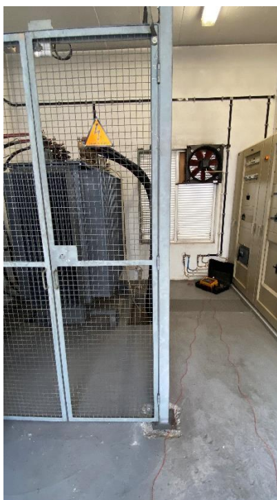
Figura 5.17 - Colocação do medidor de terras
