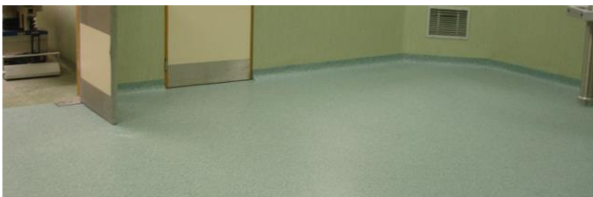
Figura 4.8 - Pavimento antiestático
