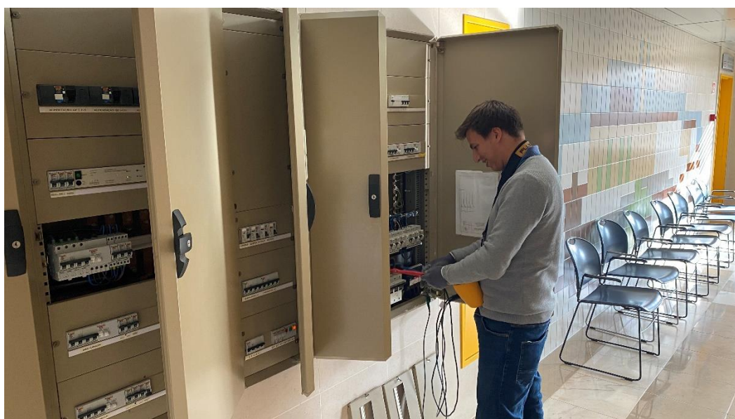
Figura 5.40 - Verificação funcionalidade proteções e avaliação dos quadros elétricos
