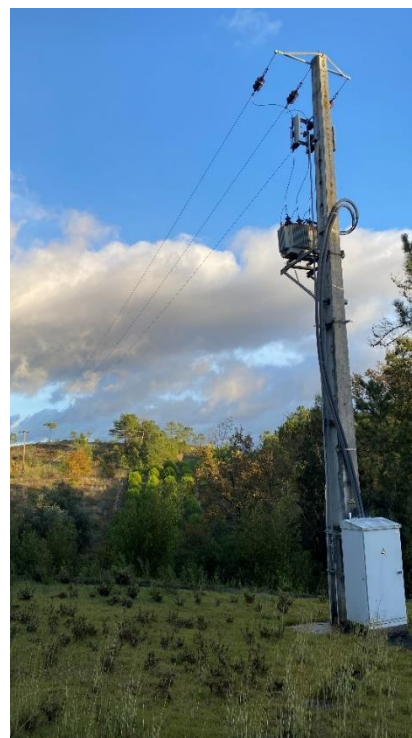
Figura 3.2 - Posto de Transformação Aéreo
