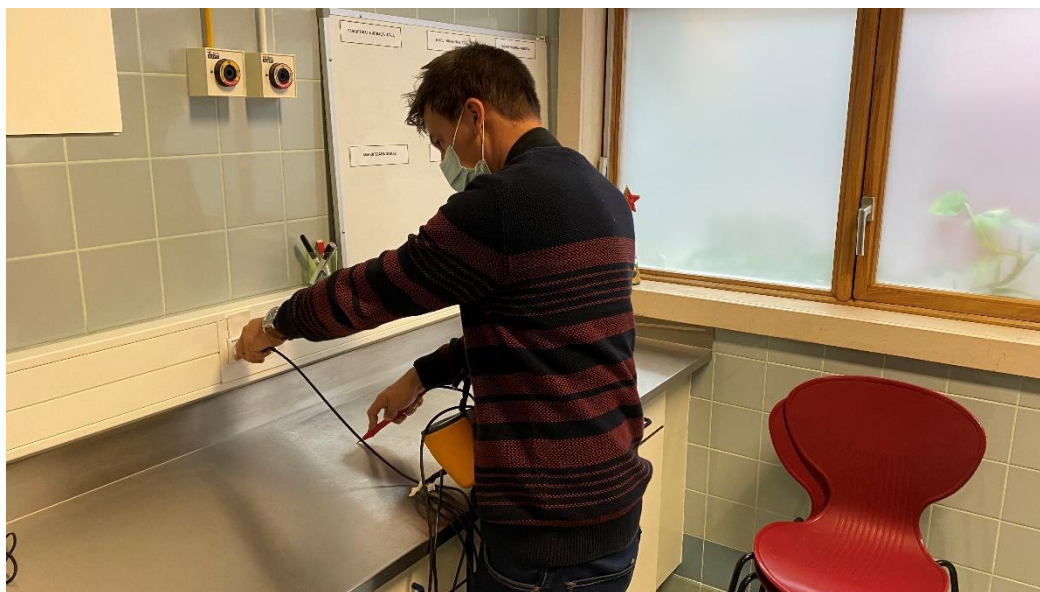
Figura 5.39 - Verificação de equipotencialidade
