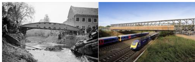
Fig. 1 – Ponte montada na 2ª Guerra Mundial na Alemanha (esquerda), e Ponte Mabey Compact 200 montada no Reino Unido (direita) [1].
