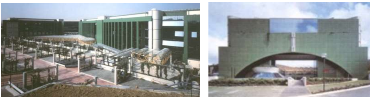
Figura 22 - Ancona, Centro Telecom Italia [36].
