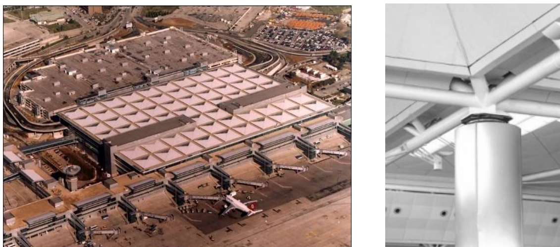
Figura 23 - Cobertura de aeroporto de Istambul equipado com apoios FPS. Adaptado de [37].
