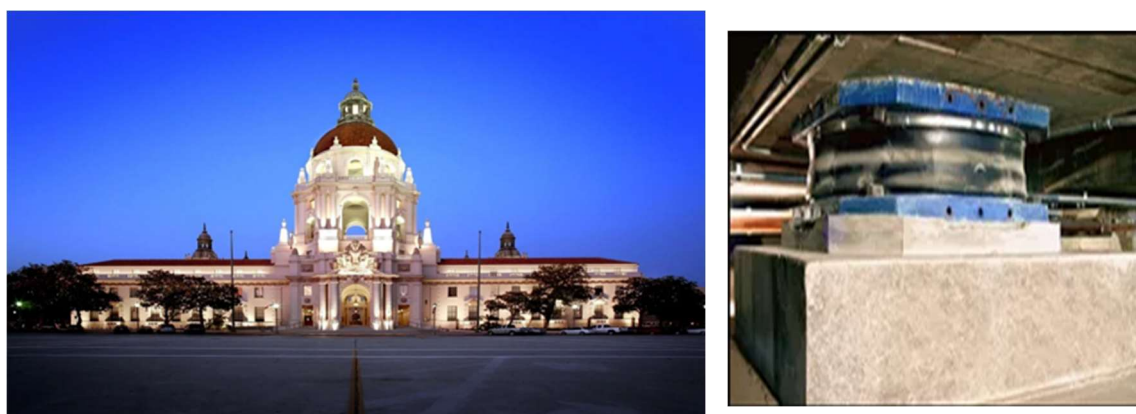
Figura 26 - Edifício City Hall, Califórnia e apoio LRB [37].
