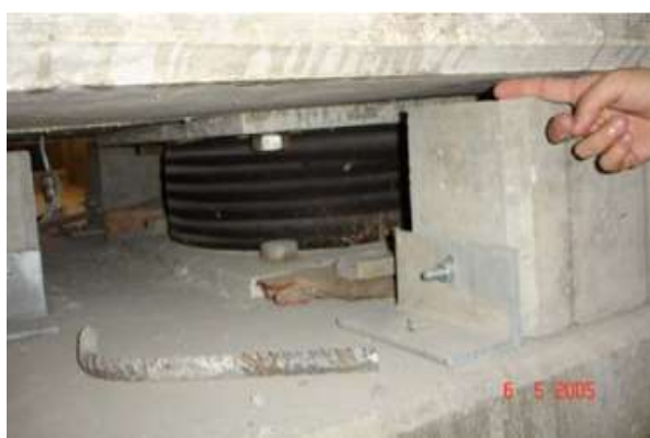
Figura 21 - Estrutura do Hospital da Luz em 2005, com isolamento de base. Adaptado de [33].
