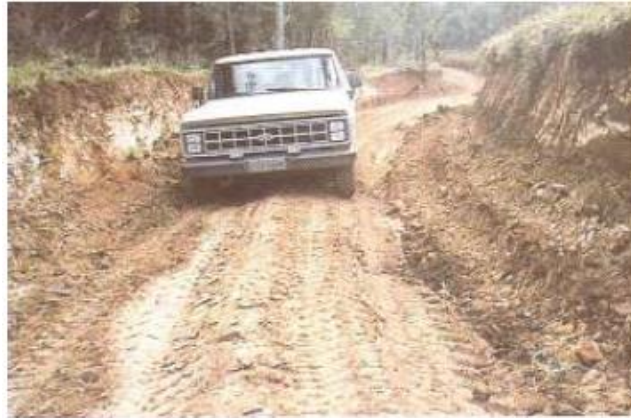
Figura 4.9 Secção transversal Imprópria (Fattori, 2007)
