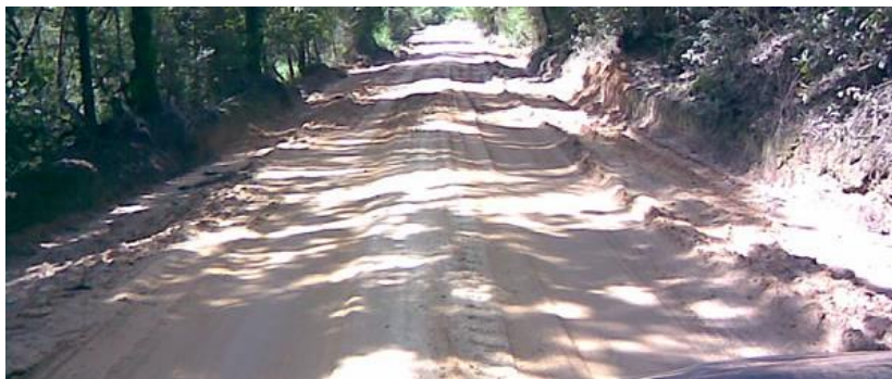
Figura 4.15 Rodeiras em pavimento não selado (Fattori, 2007)
