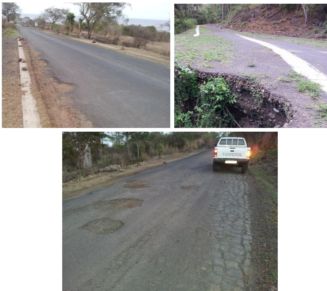
Figura 3.4 Consequências do mau estado de conservação das vias em STP
