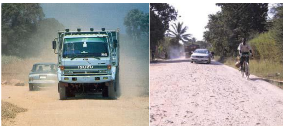
Figura 2.2 Levantamento de poeiras em estradas não pavimentadas (esquerda); Estradas de superfície áspera (direita) (SATCC, 2003)
