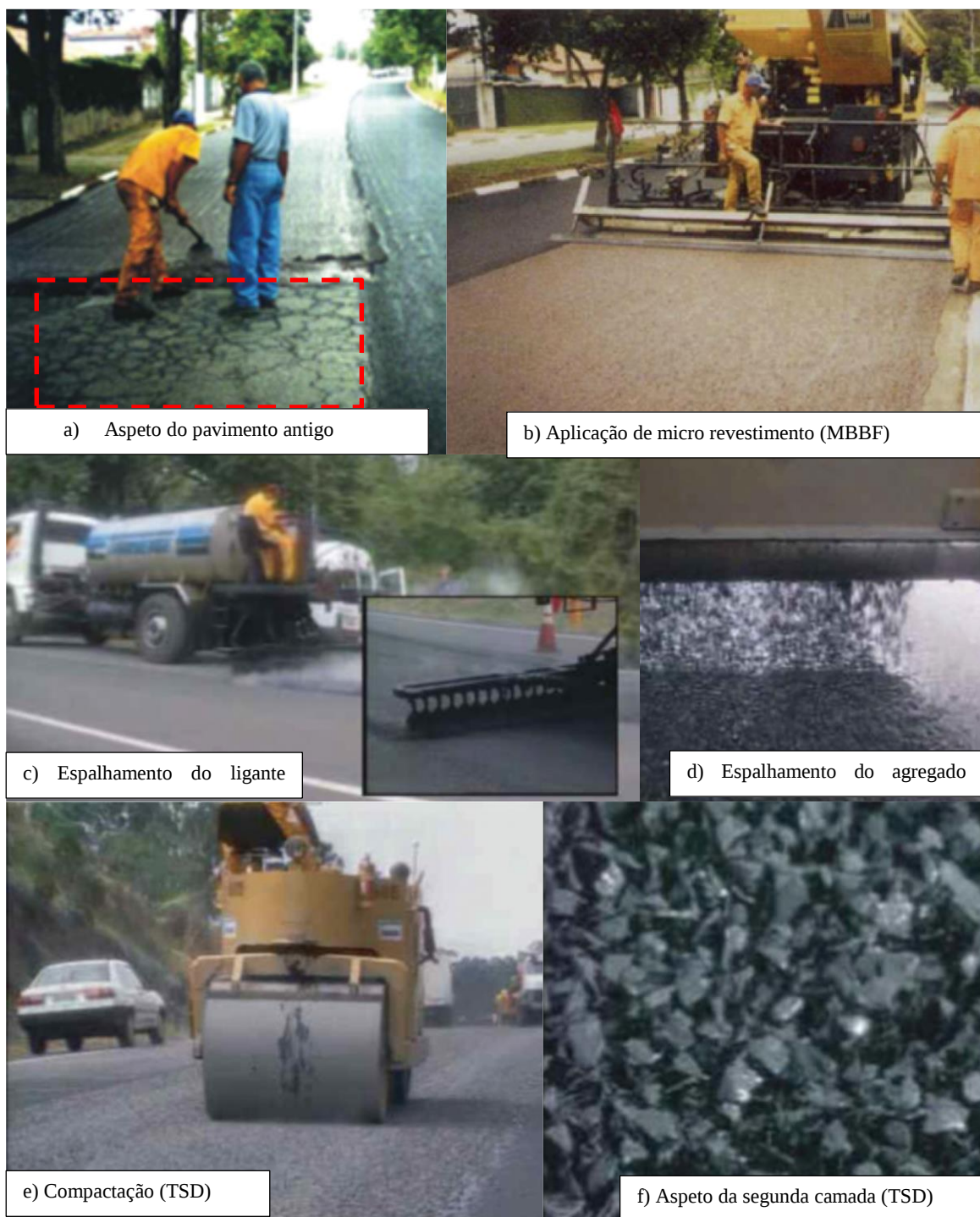
Figura 4.22 Sequência de execução de tratamentos superficiais (DER/SP, 2012).
