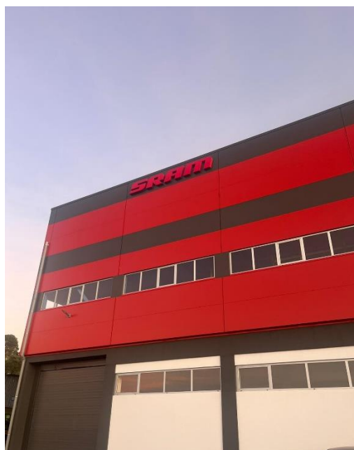
Figura 2.2 – Fábrica da SRAM em Coimbra.
