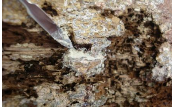
Fig. 131 – Preenchimento de uma área debilitada do verso da escultura nº 2277. Autoria própria.
