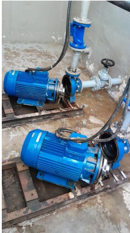
Figura 5.1 – Limpeza dos impulsores de duas bombas de uma estação elevatória
