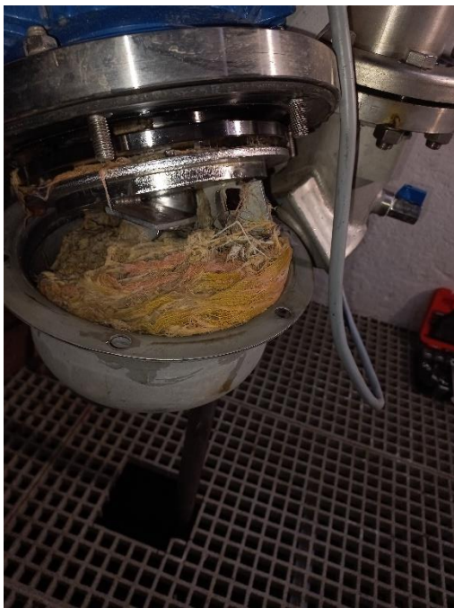
Figura 5.2 – Bomba obstruída
