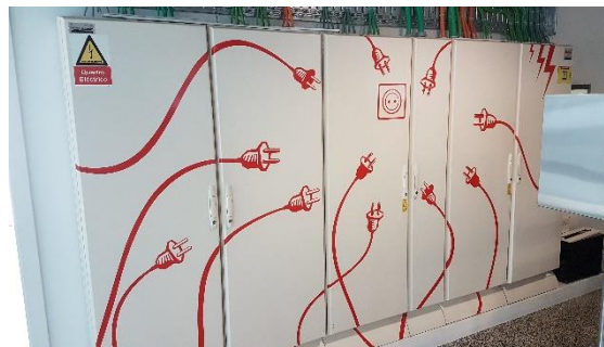
Figura 53 - Quadro geral do edifício
