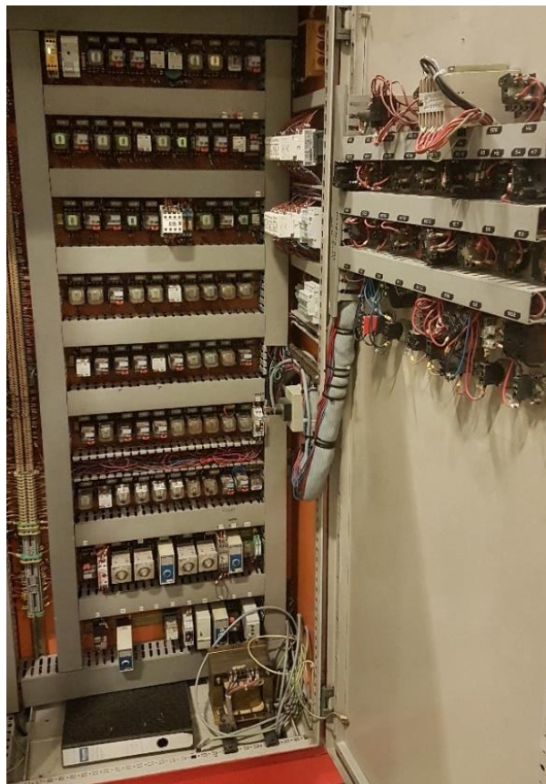
Figura 12 - Secção do quadro elétrico a remodelar
