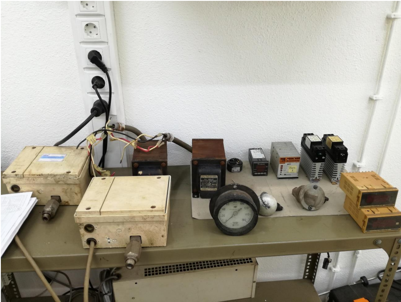
Figura 48 - Equipamentos a substituir
