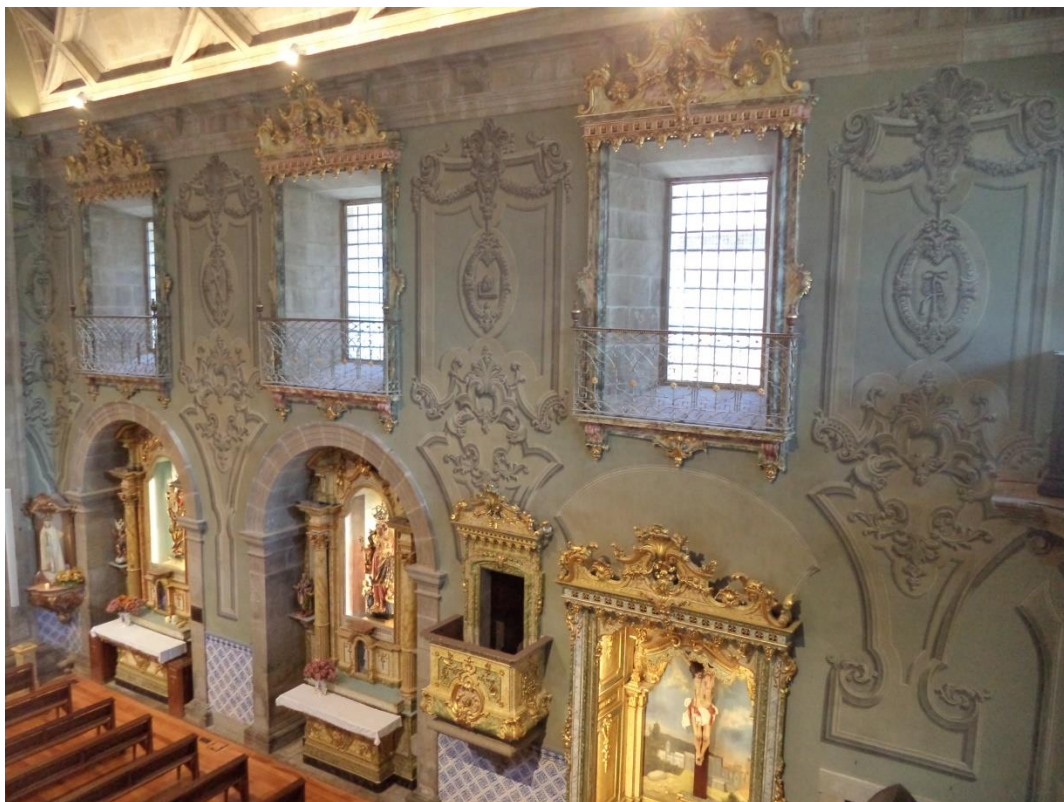
Figura 123- Fotografia após a intervenção. Fonte: autoria própria;
