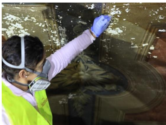
Figura 43- Processo de limpeza com etanol. Fonte: Marco Mota;
