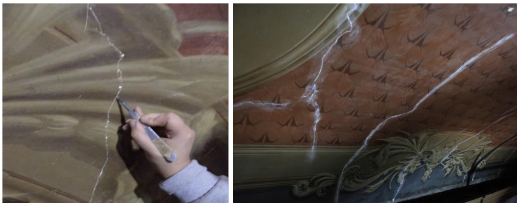
Figura 47 e 48- Fotografia ao processo de abertura de fendas e preenchimento com argamassa de gesso de estuque e cal. Fonte: autoria própria;
