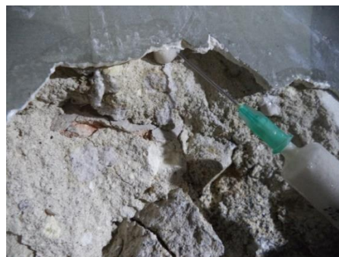
Figura 100- Fotografia da consolidação. Fonte: autoria própria;
