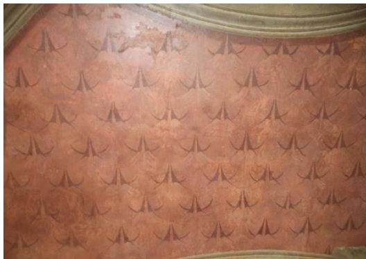
Figura 50- Pormenor da reintegração do teto da antecâmara. Fonte: autoria própria;
