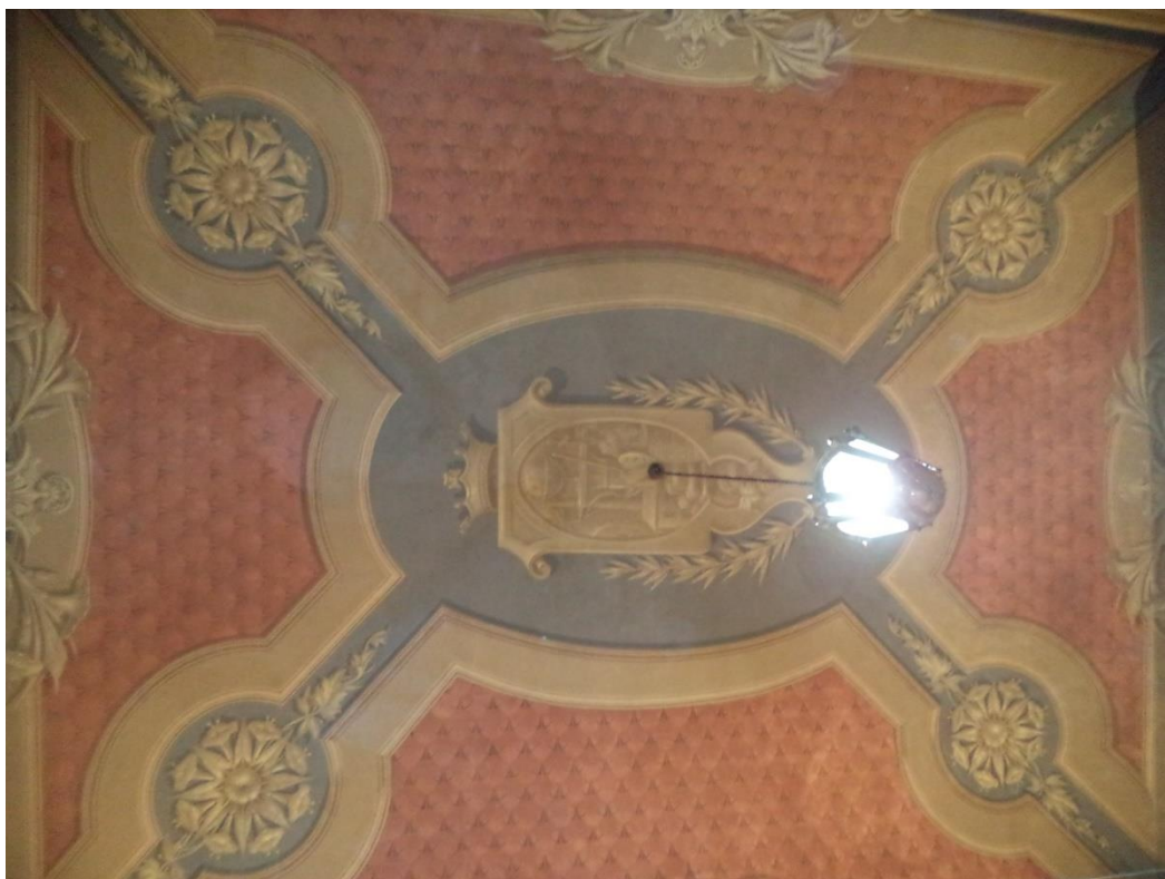
Figura 117- Fotografia do teto da antecâmara após a intervenção. Fonte: autoria própria;
