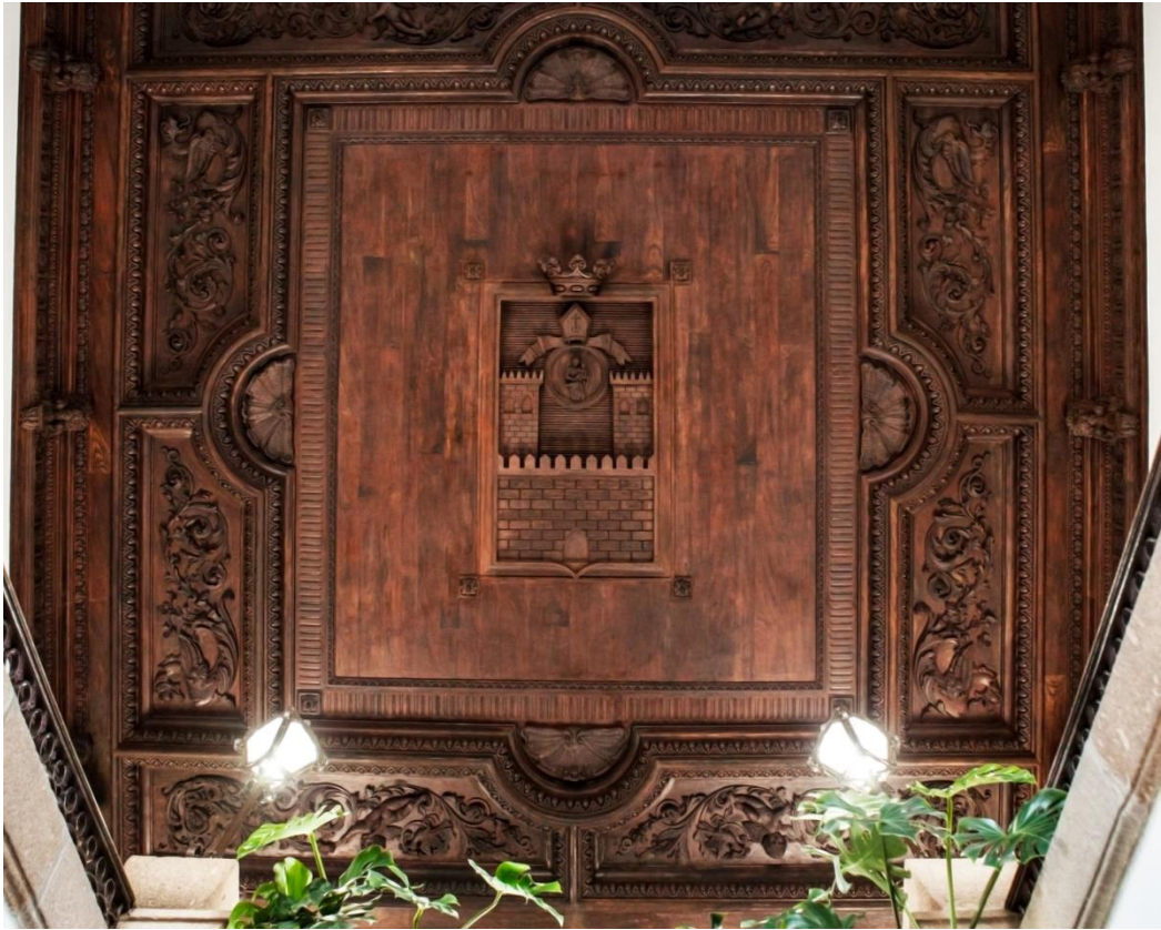
Figura 120- Fotografia do teto da escadaria após a intervenção. Fonte: Marco Mota;
