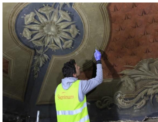
Figura 49- Fotografia ao processo de reintegração cromática. Fonte: Marco Mota;
