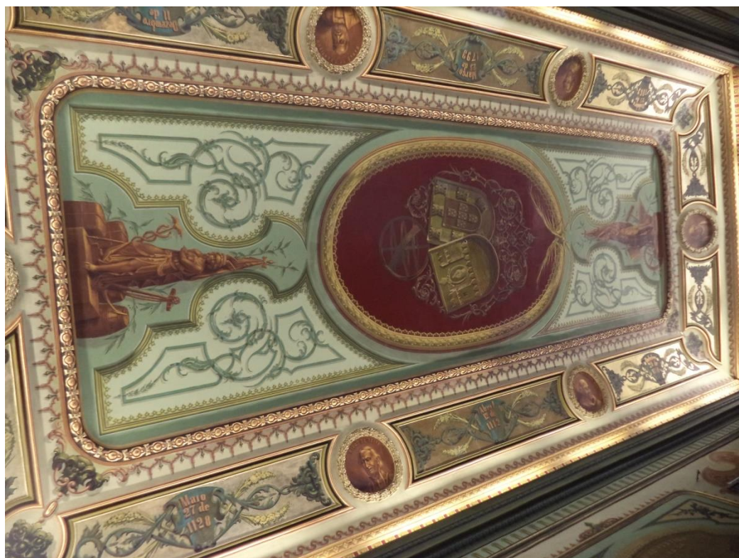
Figura 118- Fotografia do teto do salão nobre após a intervenção. Fonte: Marco Mota;
