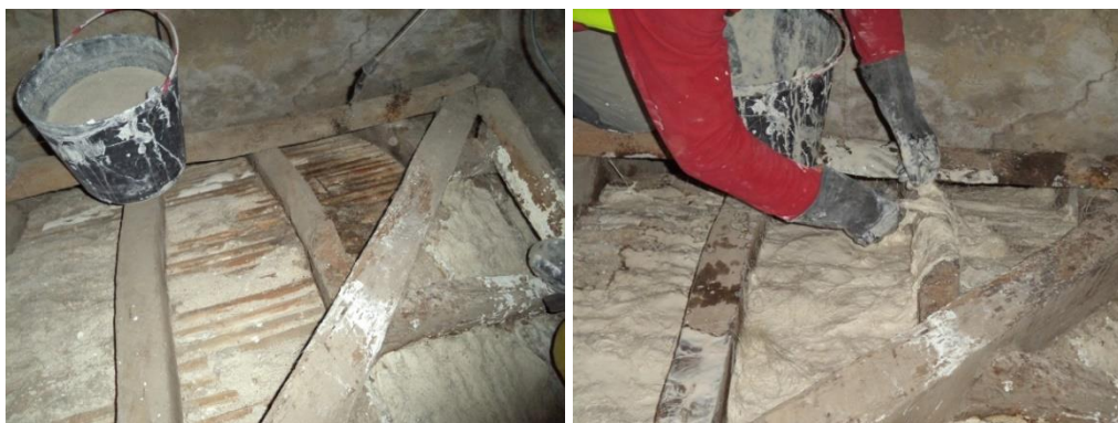
Figura 64 e 65- Elaboração do reforço da estrutura do teto. Fonte: autoria própria;
