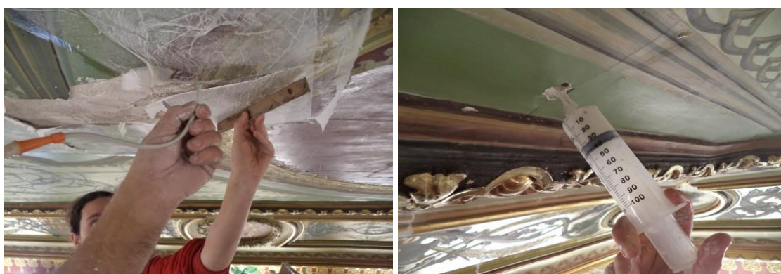
Figura 57 e 58- Fotografia à consolidação por injeção. Fonte: autoria própria;
