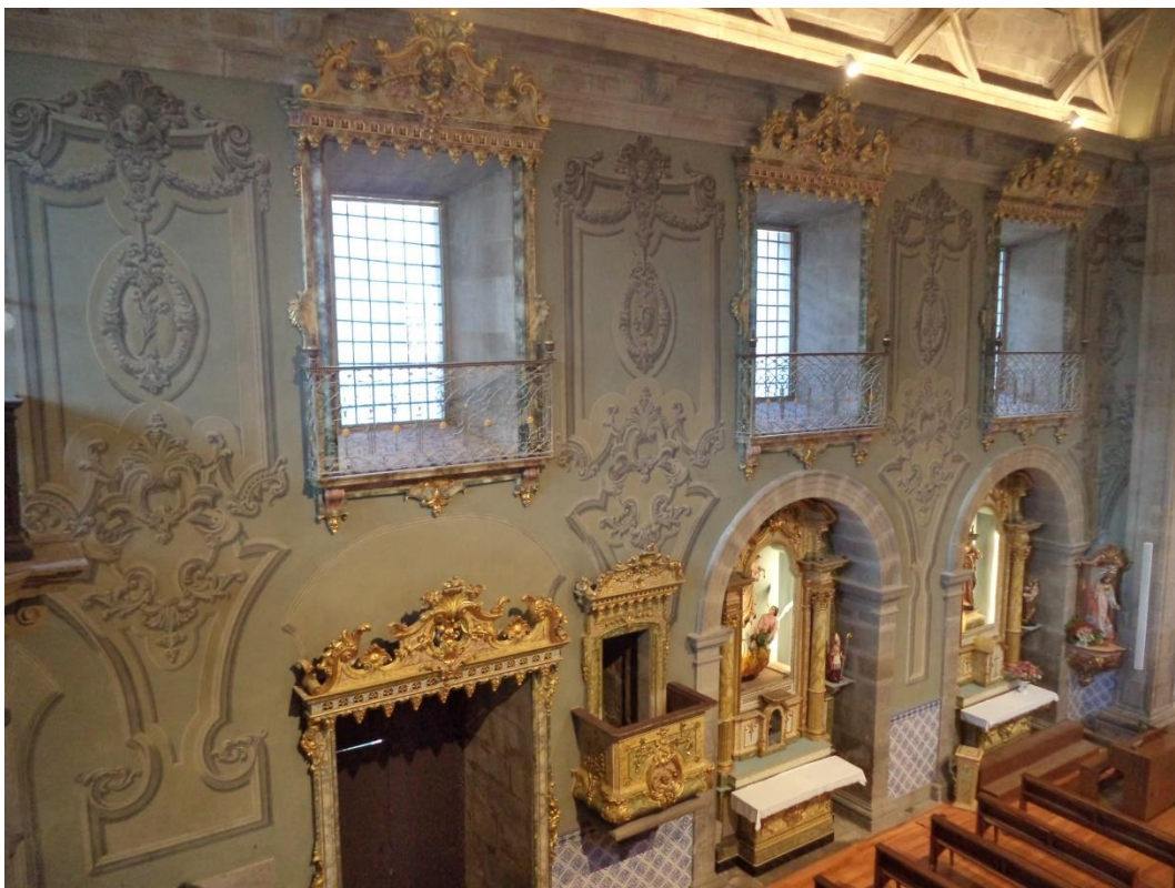
Figura 124- Fotografia após a intervenção. Fonte: autoria própria;
