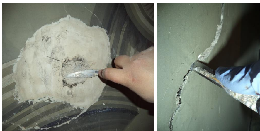
Figura 98 e 99- Fotografia do preenchimento da lacuna volumétrica e abertura de fendas. Fonte: autoria própria;
