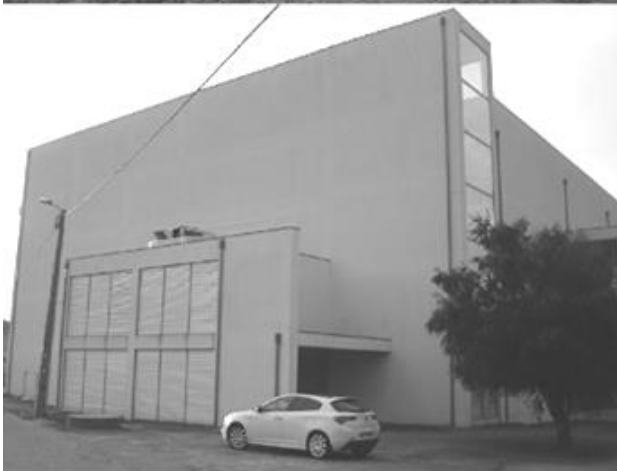
Fig. 118: Envoltório arquitetónico do EC1, EC2 e EC3 Fonte: Fotografia de autor (2014)
