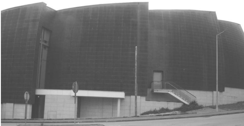
Fig. 89: Revestimento exterior EC2 Fonte: Fotografia de autor (2014)
