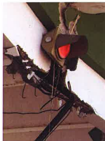
Figura 3.5 – Pormenor do elemento da grua preso à viga da pala de portagem
