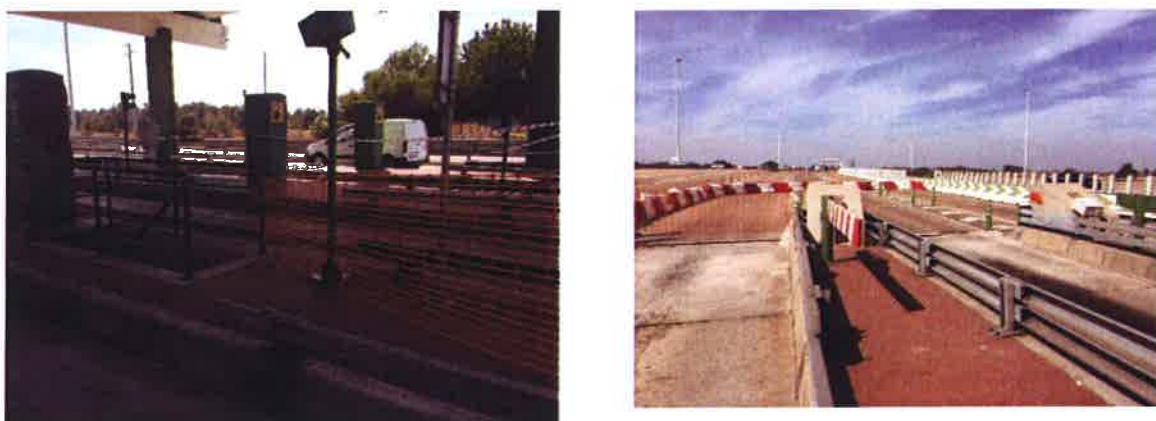
Figura 3.13 – Proteção da zona de trabalhos - Tráfego e túnel de acesso dos trabalhadores
