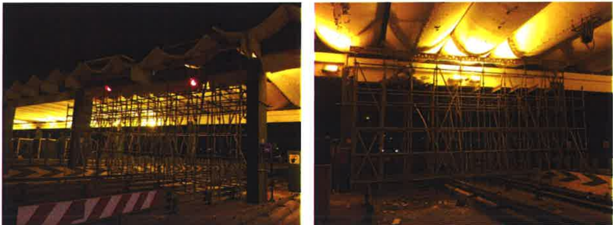
Figura 3.11 – Início de trabalhos de reparação da pala de portagem (madrugada do dia do acidente)
