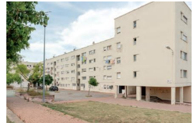
42 - Bloco Habitacional do Zambujal, Amadora
