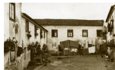
Figura 7 - Casas pátio com piso térreo e 1.º andar.
