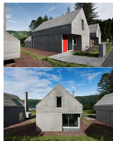
Figura 80 - Materialidade construída exterior
