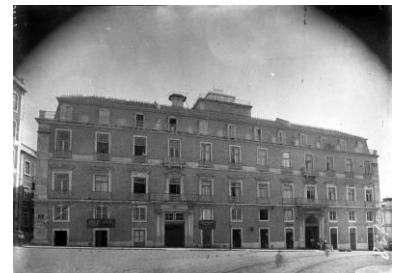
Figura 9 – Edifício em bloco
