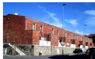
Figura 111 - Empreendimento do Telheiro
