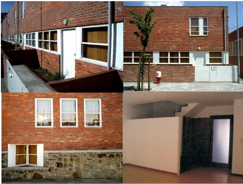
Figura 125 - Fotos Exteriores e Interiores do Empreendimento do Telheiro
