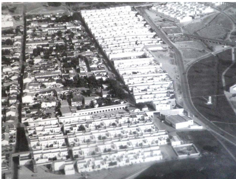
Figura 65 - Parte das habitações da Quinta da Malagueira
