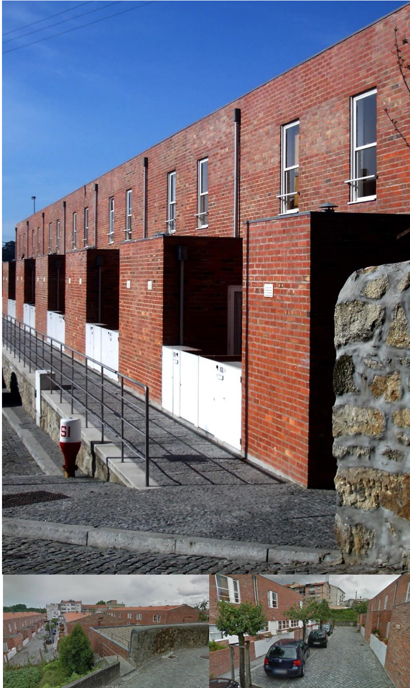
Figura 124 - Fotos Exteriores do Empreendimento do Telheiro
