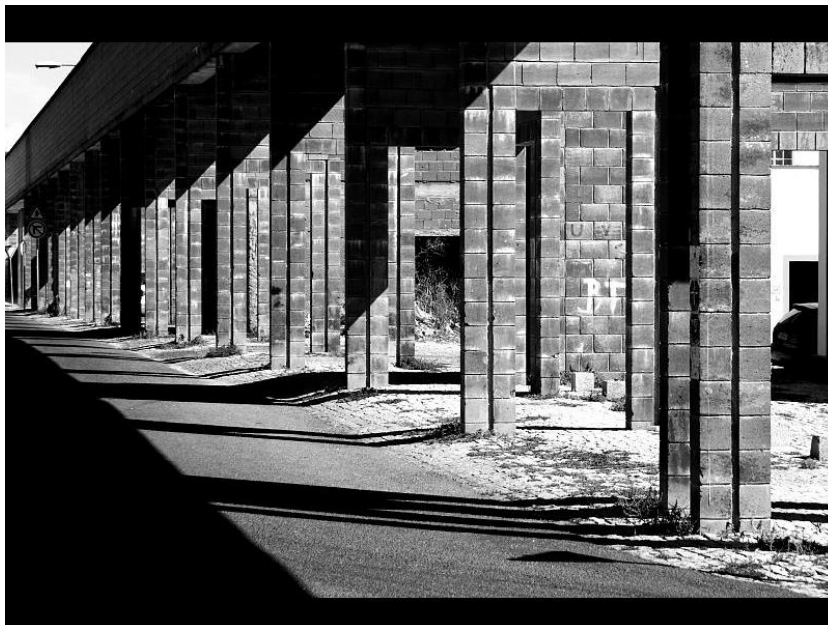
Figura 76 - Estrutura principal do "Aqueduto" da Quinta da Malagueira que posteriormente ramifica para as habitações
