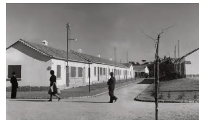
Figura 35 - Habitações de 1 piso
