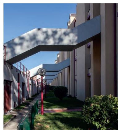
51 - Acesso entre volumes de garagens e de habitações
