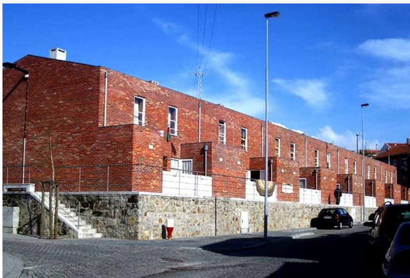
Figura 122 – Fotos Exteriores do Empreendimento do Telheiro
