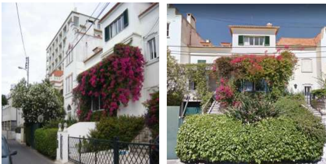
Figura 42. Fachada do edifício.
