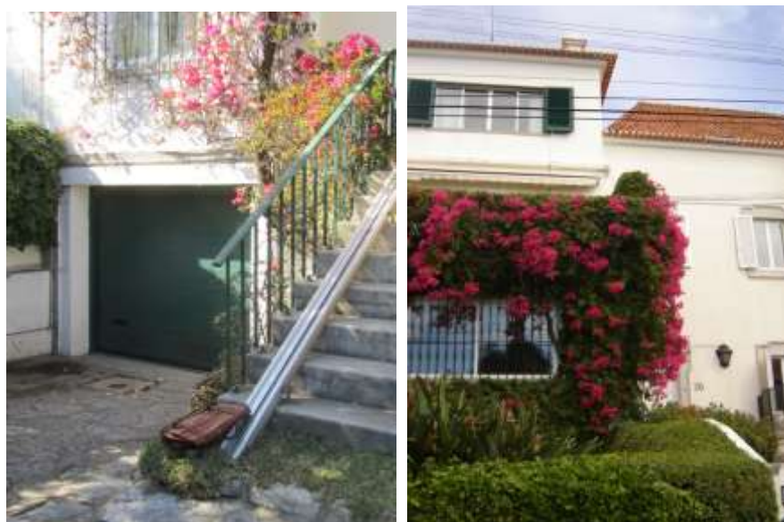
Figura 43. Pormenores da fachada do edifício e acesso à garagem.
