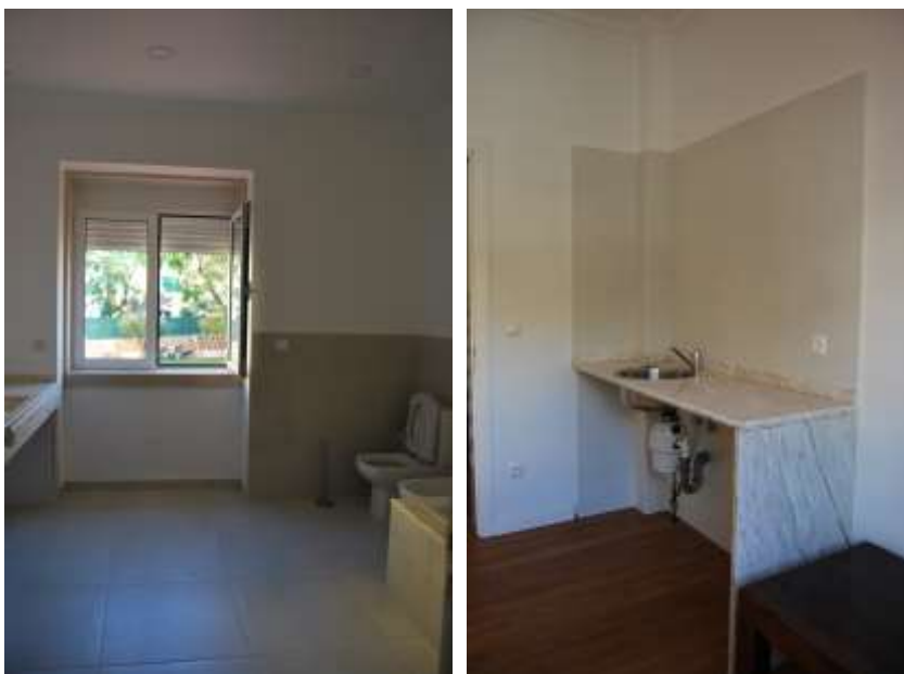
Figura 49. Uma das instalações sanitárias do piso 1.
